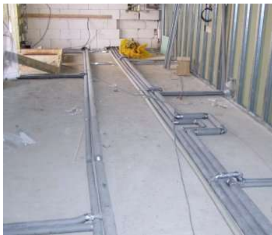
Obrázek 11: Izolační vyrovnávací vrstva pro vedení instalací
