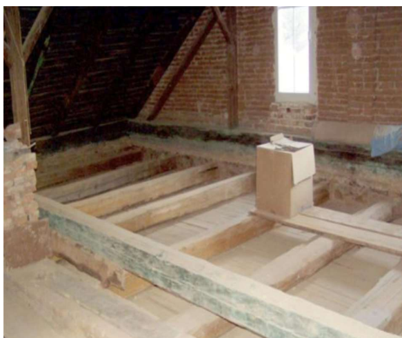
Obrázek 12: Použití pro vytvoření lehké roznášecí, vyrovnávací vrstvy podlah (rekonstrukce) [23]
