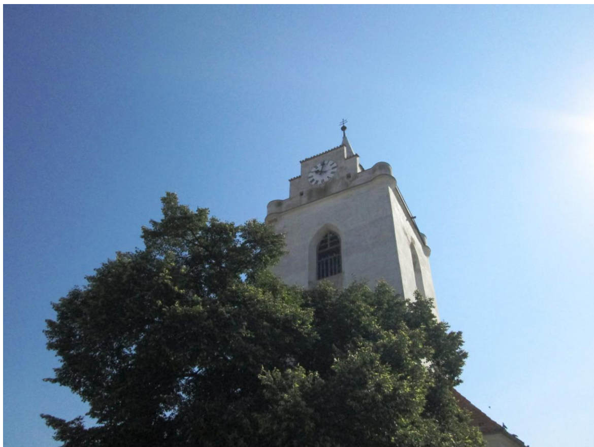
Obr. 7.1: Pohled na věž kostela
