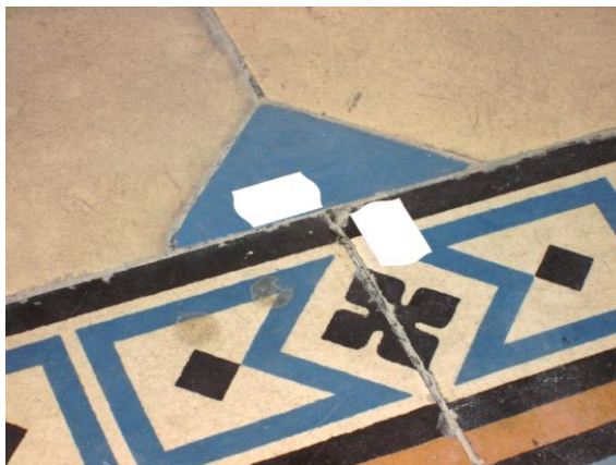
Obr. 3.3: Dočasná stabilizace v interiéru kostela
