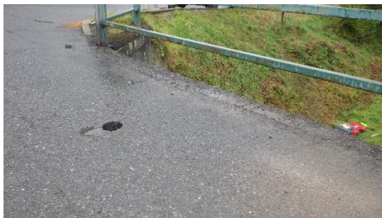
Obrázek 29: Celkový pohled na místo odběru vývrtu VD1 skrz skladbu vozovky
