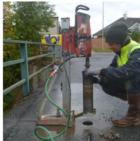
Obrázek 15: Zjišťování skladby vozovky pomocí jádrového vrtání
