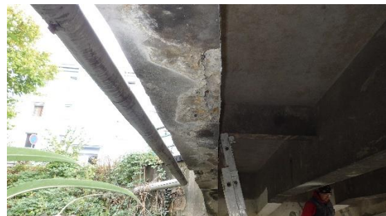
Obrázek 30: Pohled na chybějící krycí vrstvu betonu u nosníku číslo 1
