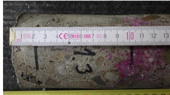
Obrázek 24: Detail měření hloubky karbonatace tělesa z výmrtu VN1 – pravá strana tělesa
