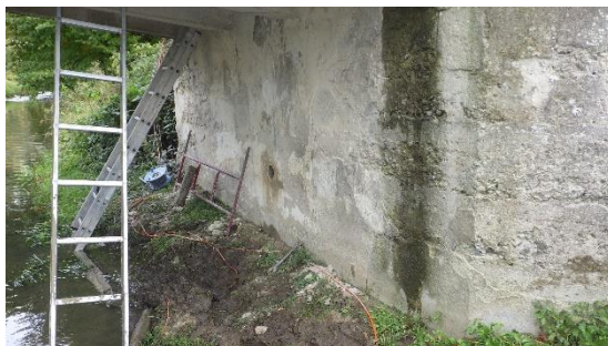
Obrázek 7: Celkový pohled na místo odběru vývrtu VOP2
