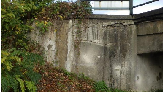
Obrázek 26: Pohled na pravé křídlo opěry OP1
