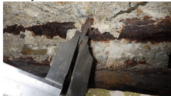
Obrázek 45: Foto měření průměru třmínku posuvným měřítkem
