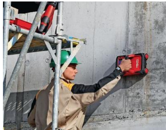
Obrázek 13: Lokalizování výztuže pomocí přístroje Hilti PS 1000 [23]
