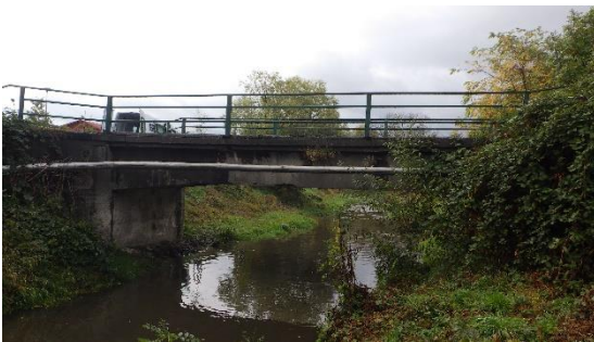
Obrázek 35: Ocelová chránička zavěšená pomocí táhel
