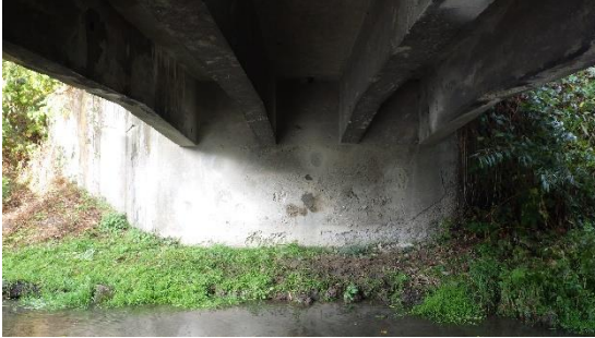
Obrázek 22: Pohled na opěru OP1
