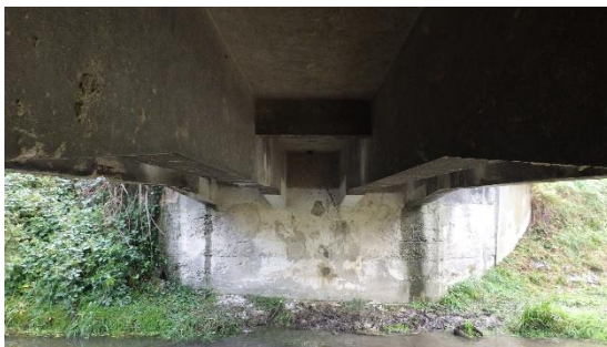
Obrázek 29: Pohled na nosnou konstrukci mostu
