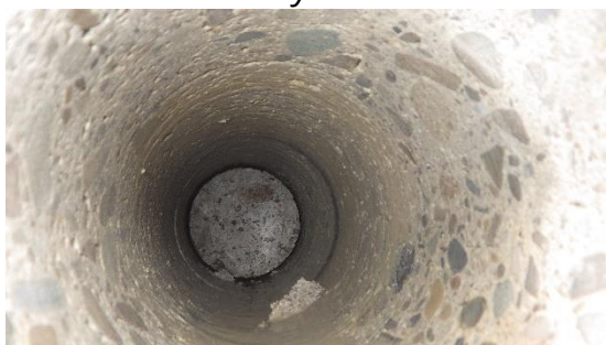
Obrázek 17: Detailní foto ostění vývrtu VKP2
