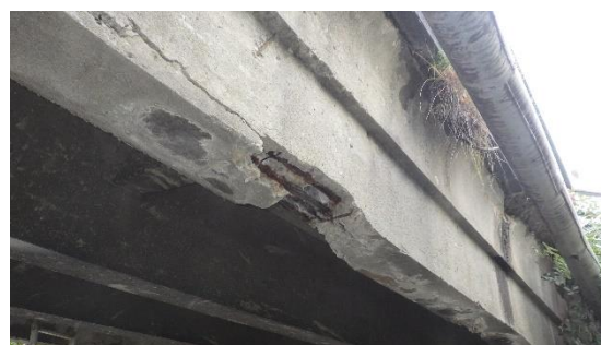
Obrázek 39: Celkový pohled na sekanou sondu SVT1 z vnější strany trámu
