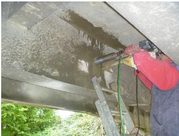
Obrázek 14: Odebírání jádrového vývrtu z trámového nosníku
