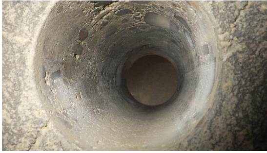
Obrázek 21: Detailní foto ostění výmrtu VN1
