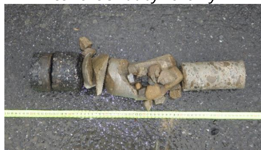
Obrázek 36: Foto skladby vozovky
