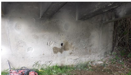
Obrázek 1: Celkový pohled na místo odběru vývrtu VOP1
