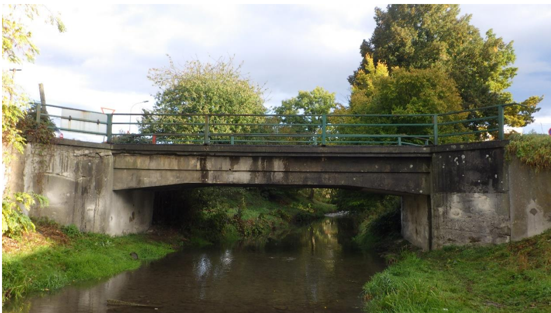
Obrázek 21: Celkový pohled na most ev. č. 204c – M1 z pravé strany
