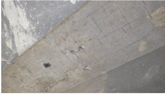
Obrázek 55: Celkový pohled na provedenou sekanou sondu SVD1
