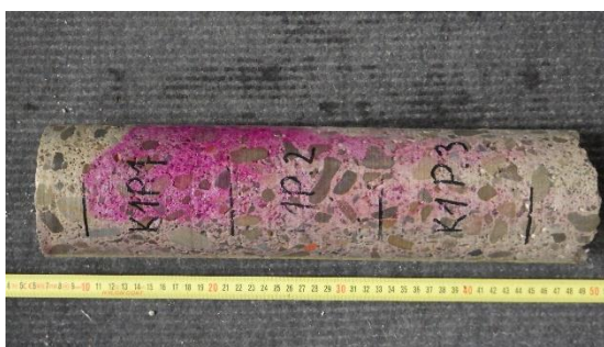
Obrázek 17: Stanovení hloubky karbonatace fenolftaleinovým testem na jádrovém vývrtnu
