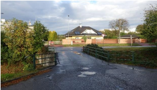
Obrázek 31: Celkový pohled na vozovku, v předpolí jsou vidět lokální výtluky
