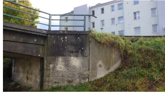
Obrázek 27: Pohled na pravé křídlo opěry OP2
