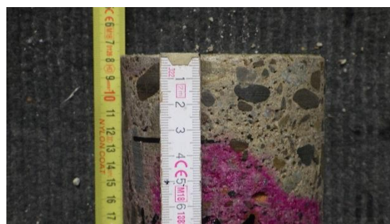
Obrázek 18: Hloubka karbonatace na jádrovém vývrtnu dosahující hloubky 40 až 60 mm
