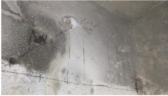
Obrázek 49: Celkový pohled na provedenou sekanou sondu SVT2
