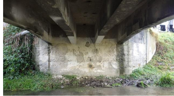
Obrázek 23: Pohled na opěru OP2
