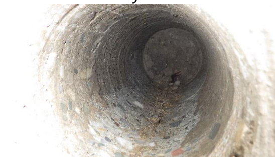
Obrázek 13: Detailní foto ostění vývrtu VKP1
