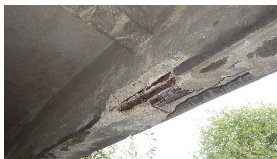
Obrázek 38: Celkový pohled na sekanou sondu SVT1 z vnitřní strany trámu
