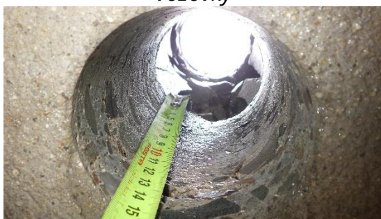
Obrázek 31: Detailní foto ostění vývrtu VD1
