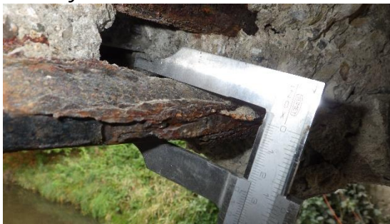
Obrázek 44: Foto měření průměru hlavní nosné výztuže, výztuž značně zkorodována, šupinková koroze výztuže
