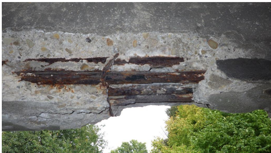
Obrázek 16: Sekaná sonda provedená na trémovém mostě
