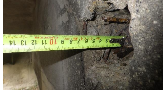
Obrázek 52: Foto měření krycí vrstvy ohybu hlavní nosné výztuže
