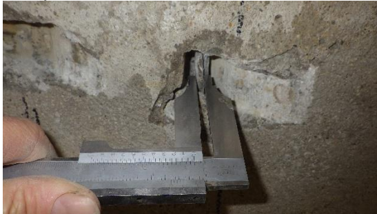
Obrázek 57: Foto měření průměru výztuže pomocí posuvného měřítka
