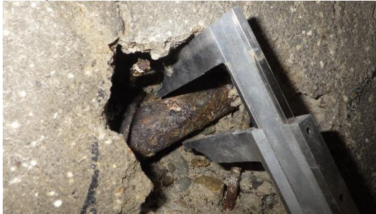
Obrázek 51: Foto měření průměru výztuže pomocí posuvného měřítka
