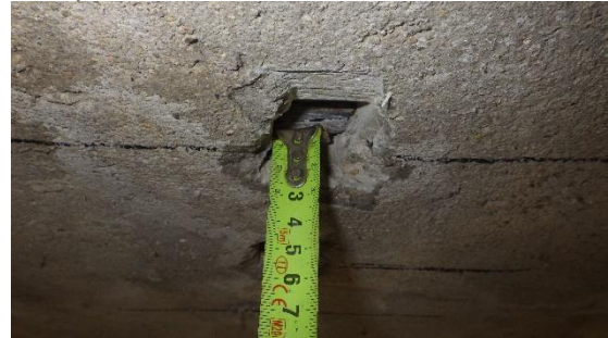
Obrázek 58: Foto měření krycí vrstvy hlavní nosné výztuže
