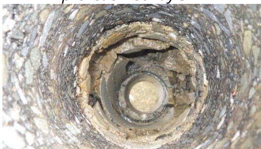
Obrázek 35: Detailní pohled na jednotlivé vrstvy vozovky
