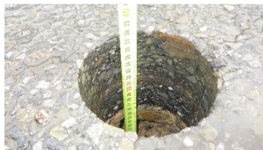
Obrázek 34: Detailní foto měření celkové skladby vozovky
