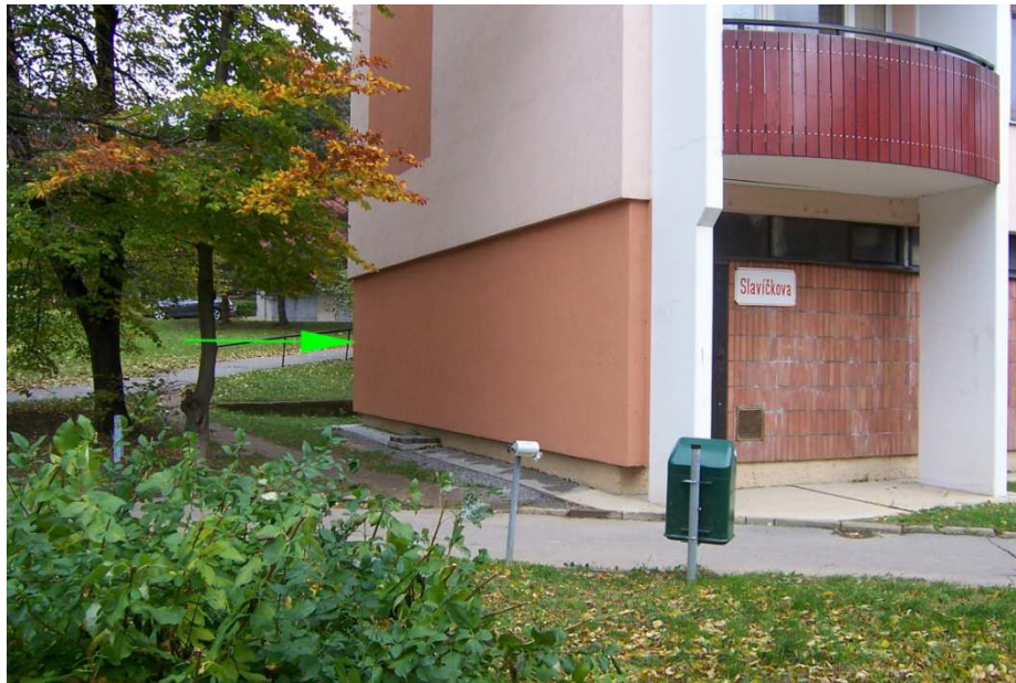
Obr. č. 14 – Stabilizace PPBP – roh budovy
