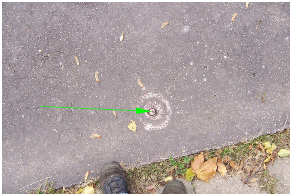
Obr. č. 16 – Stabilizace PPBP – měřickým hřebem
