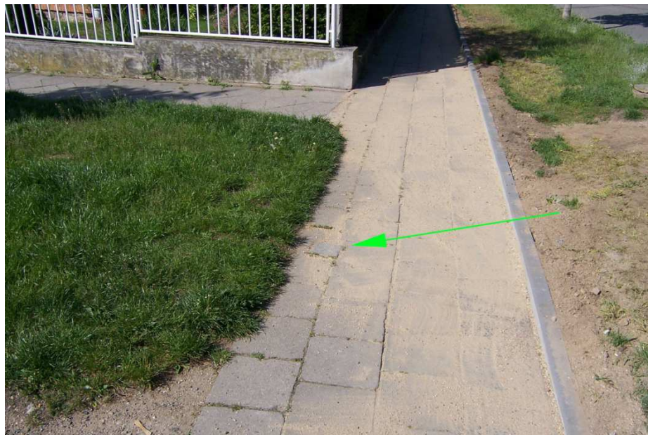
Obr. č. 15 – Stabilizace PPBP – kámen s vytesaným křížkem
