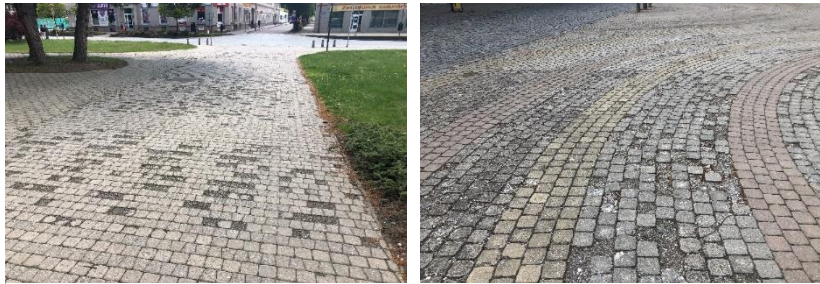
Obrázek 28: Poškozená dlažba
