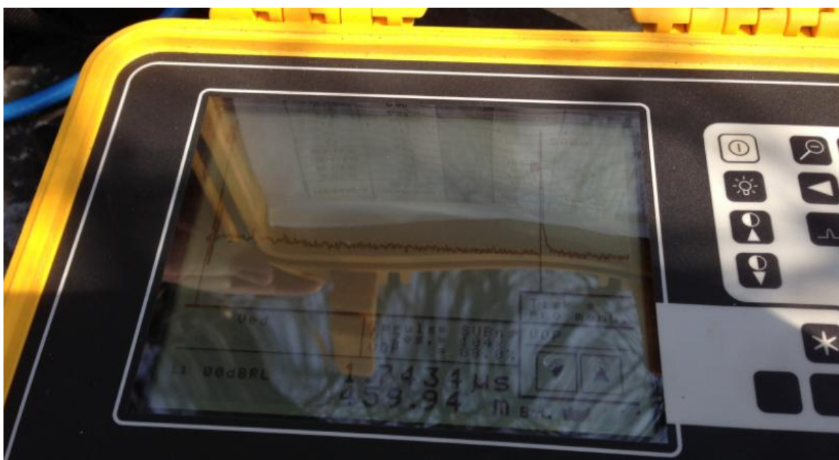
Obr. 9 Měření délky koaxiálního kabelu
