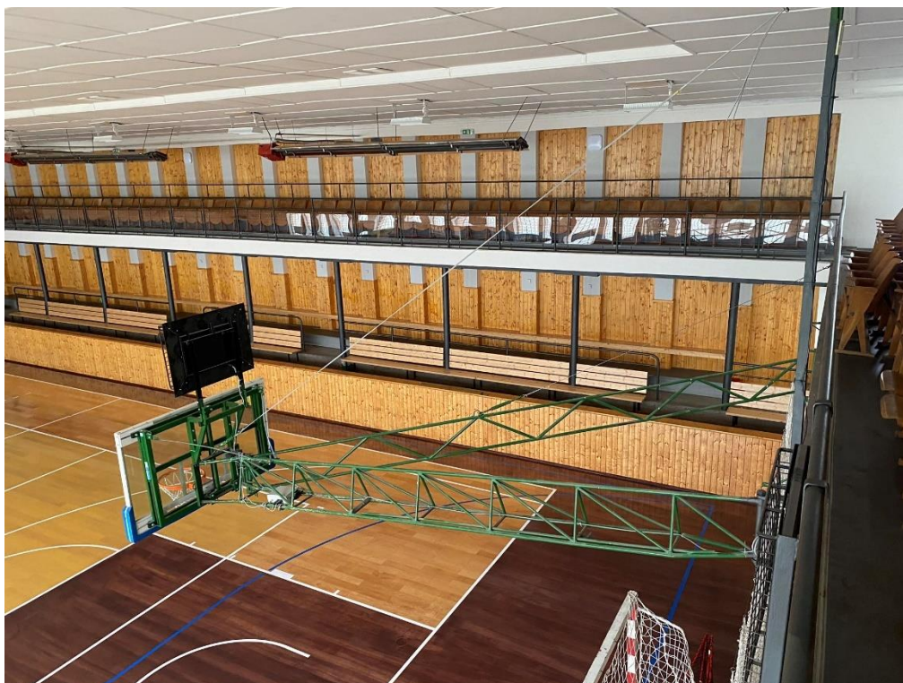
Obrázek 11 Pohled na konstrukci
