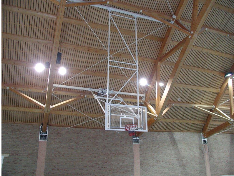
Obrázek 6 Basketbalová konstrukce ukotvená na stropě[19]
