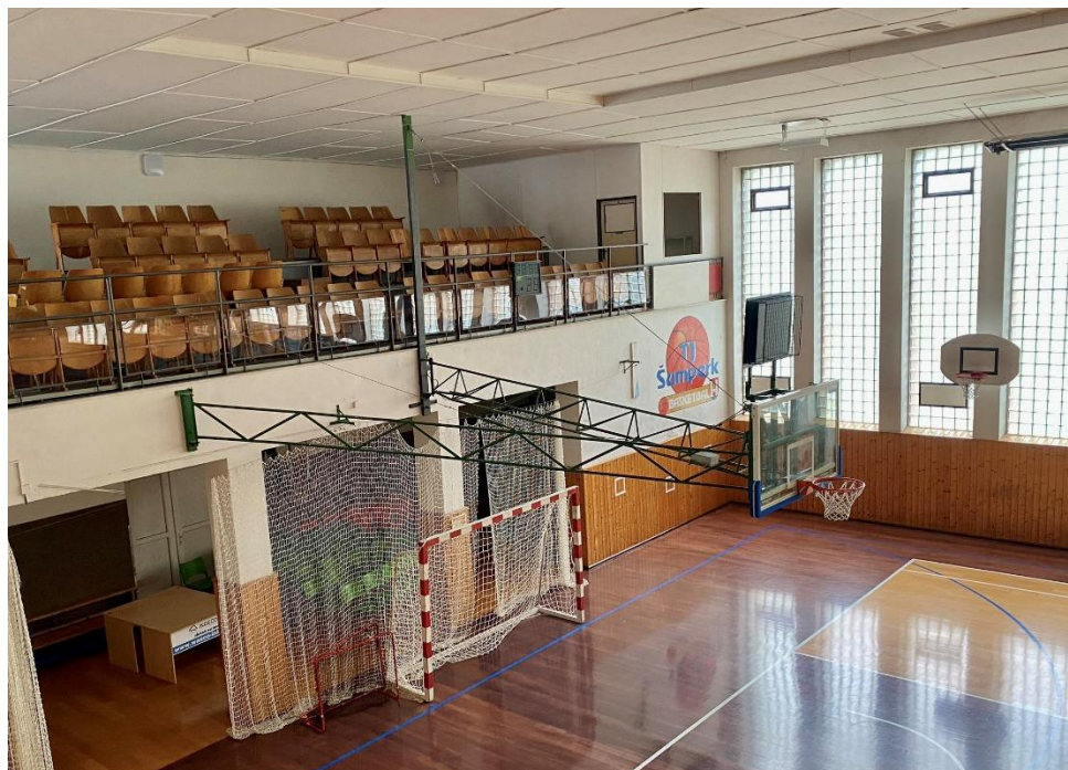
Obrázek 10 Konstrukce držící basketbalový koš
