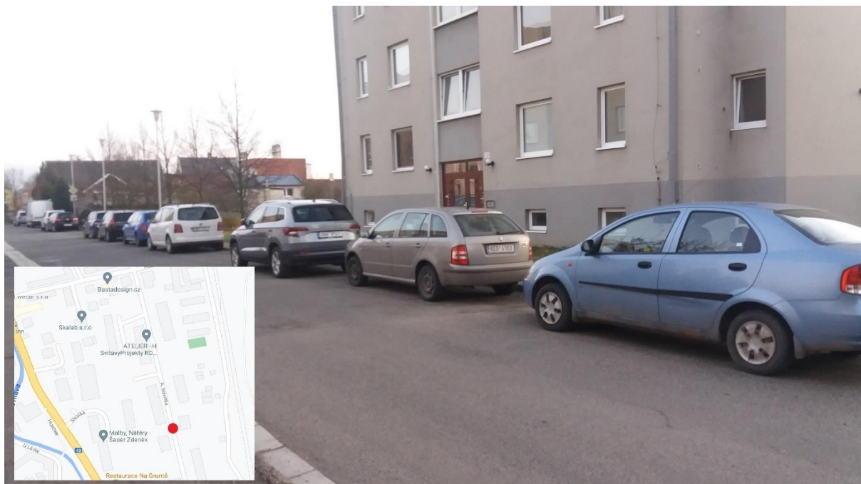
Obr. č.: 7 Ulice Antonína Slavička – nedostačující šířka průjezdu c)
