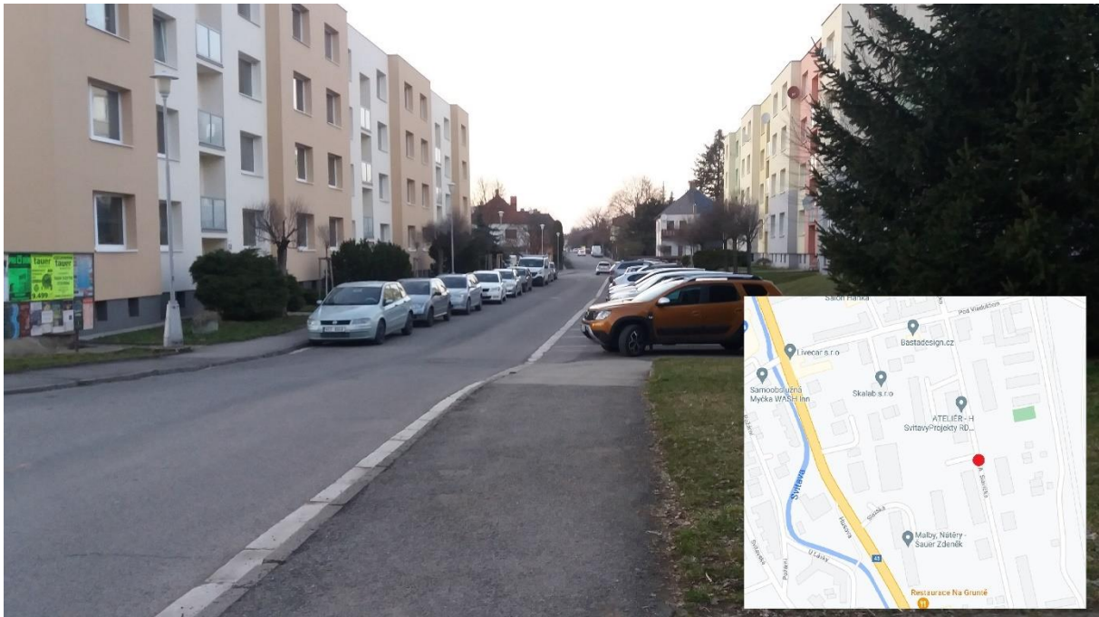
Obr. č.: 5 Ulice Antonína Slavička – nedostačující šířka průjezdu a)
