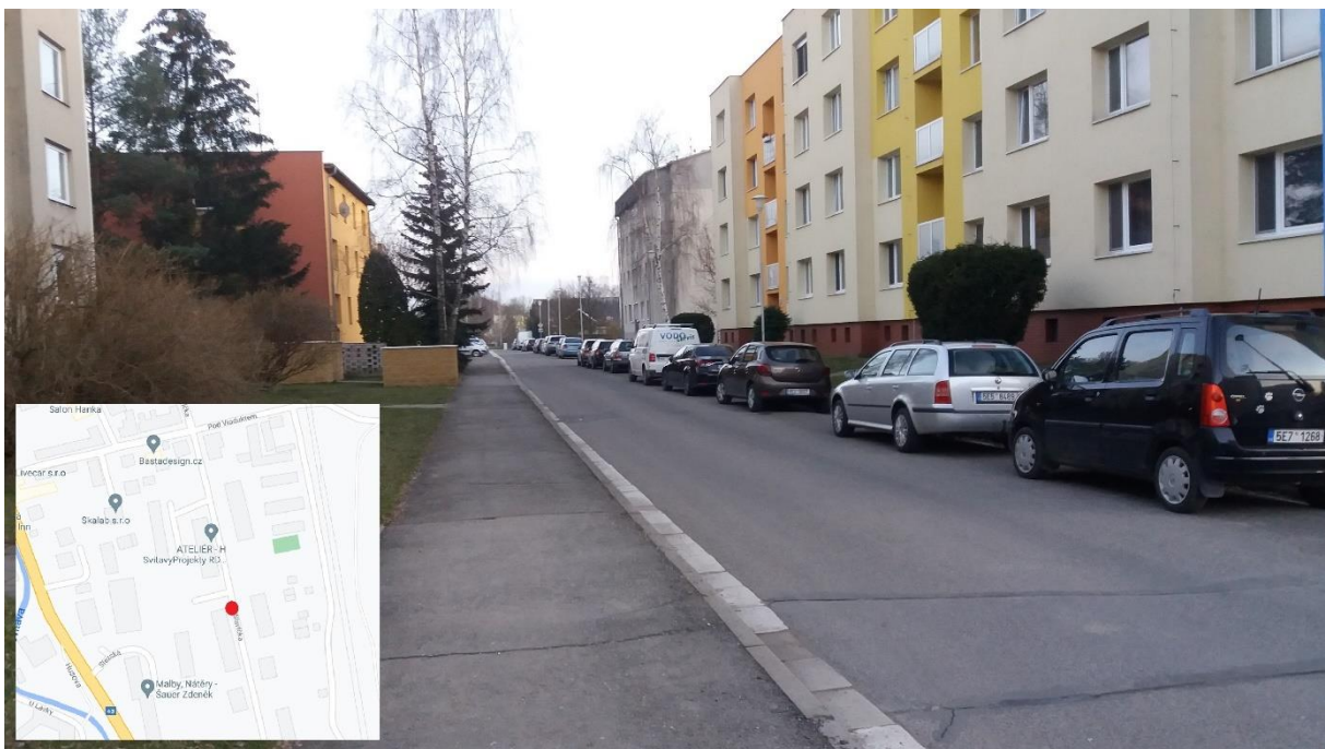
Obr. č.: 6 Ulice Antonína Slavička – nedostačující šířka průjezdu b)
