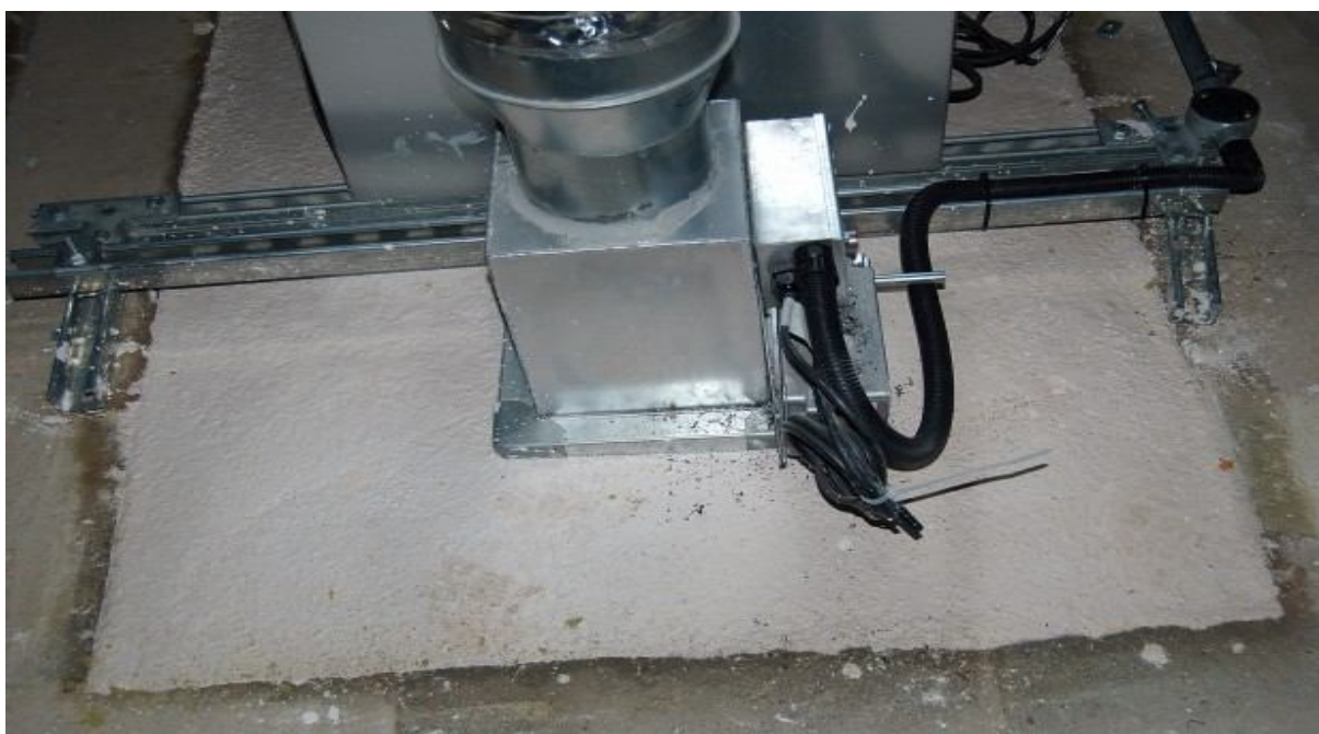
Obrázek 7-Řešení průchodu vzduchotechniky podlahou pomocí protipožární malty [25]
