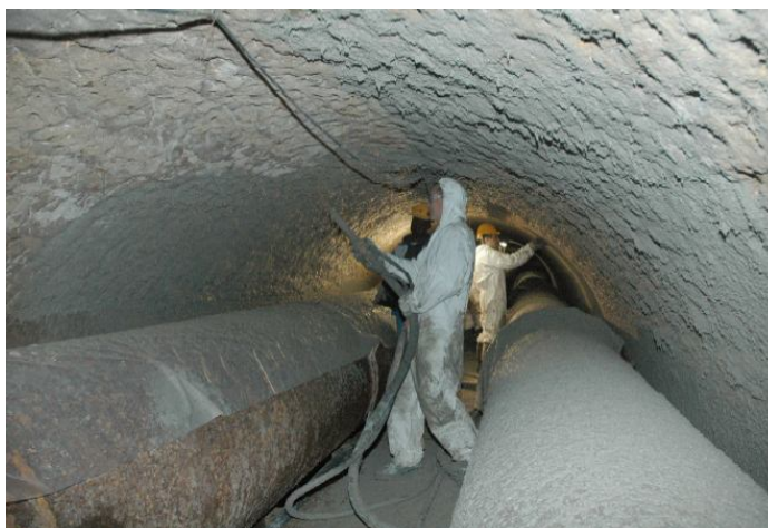
Obrázek 8 – Mokrý způsob nanášení správkové hmoty stříkáním [29]
