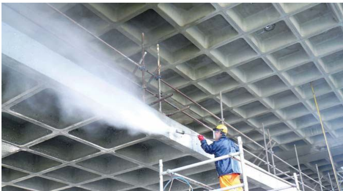
Obrázek 9 – Nanášení inhibitoru koroze na před upravený povrch betonové konstrukce [41]
