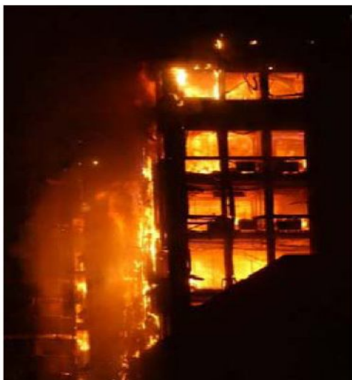
Obrázek 4- Požár v budově Windsor Tower, Madrid [17]
