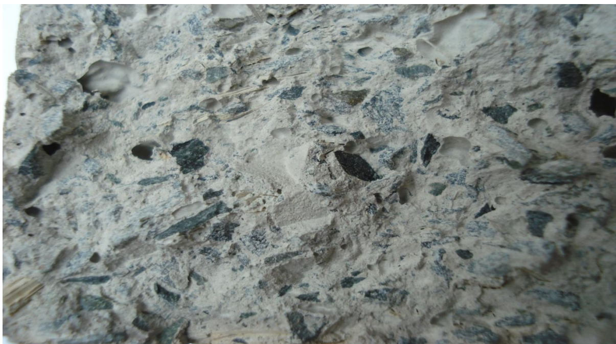
Obrázek 26 – Lomová plocha receptury obsahující pouze kamenivo amfibolit. Sanační malta s poměrem kameniva ku cementu 4 : 1 (zatěžovací teplota 600 °C)
