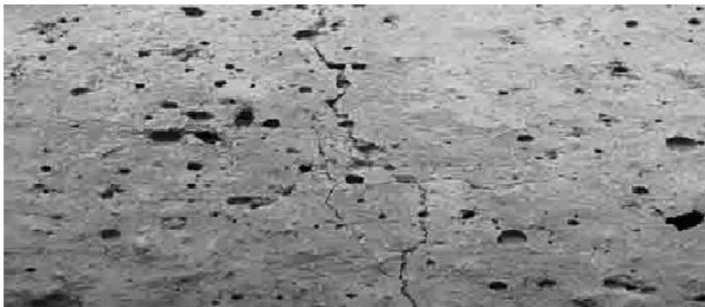
Obrázek 11- Typický vzor porušení polymer-cementového kompozitu po zkoušce požární odolnosti [9]
