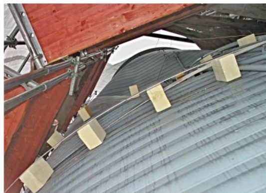
Obr. 3.4. Boulení stěny vertikální nádrže (pohled zespuď nahoru) [15]
