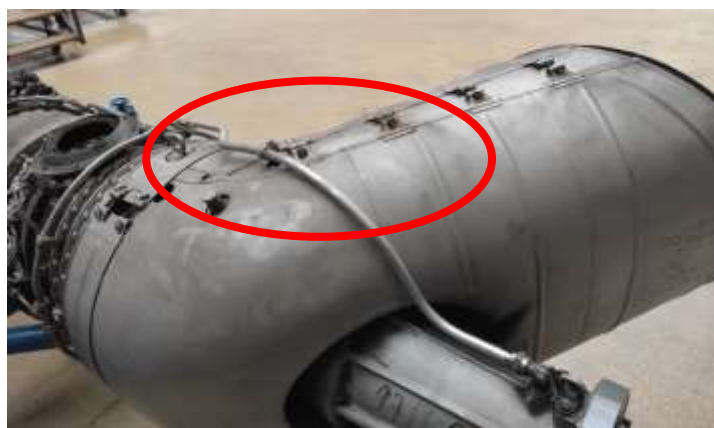
Obrázek 5.20: Koroze spojů v oblasti výfuku
