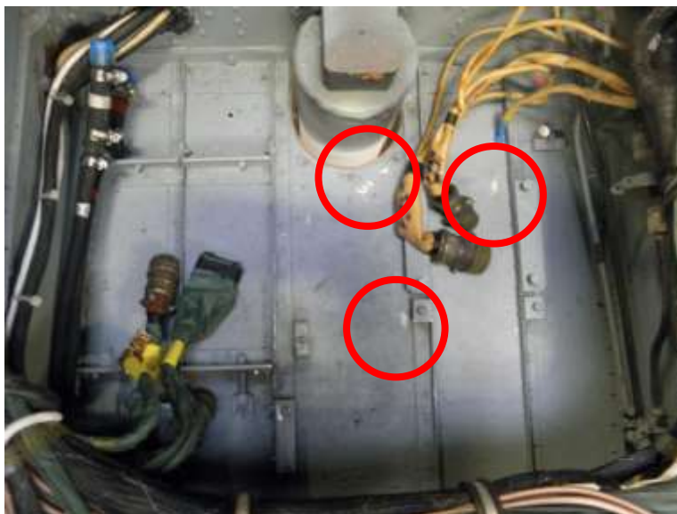
Obrázek 5.12: Koroze šachty podvozku
