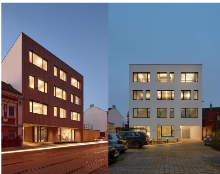
Obrázek 2 a 3: Fotografie řešeného objektu z ulice Dukelská třída a z vnitrobloku
