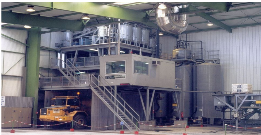
Obrázek 4 - Stabilní solidifikační linka [SITA]
