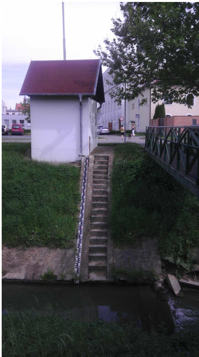
Obr. 6.11 Řiční km 51,345 betonový stupeň s odečtem hladiny a hydrologický objekt
