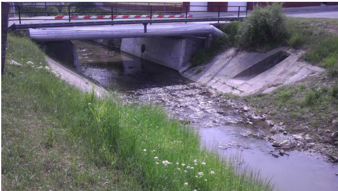
Obr. 6.12 Řiční km 52,223 silniční betonový most s dešťovou výpustí
