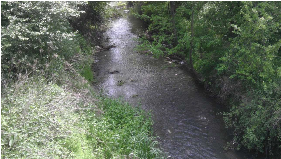
Obr. 6.3 Řiční km 54,162 břehy koryta extravilánu
