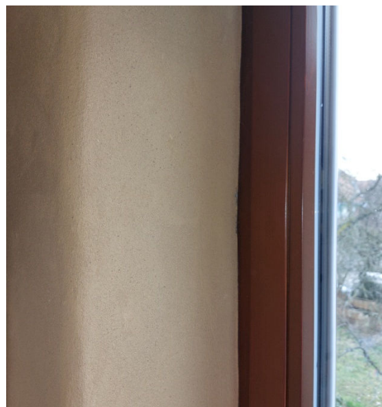
Obr. 4 – Detail provedení zaobleného ostění okna v RD autora v Brně-Kníničkách (archiv autora)
