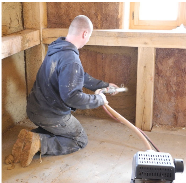
Obr. 12 - Strojové omítání slaměného rodinného domu v Ludvíkově hliněnou omítkou (archiv autora)
