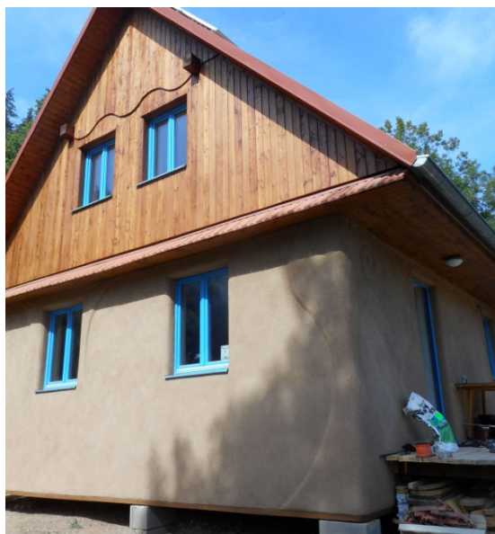
Obr. 3 – Provedení hran hliněných omítek na ostěních a nárožích domu v areálu střediska ekologické výchovy Kaprálov mlýn (archiv autora)
