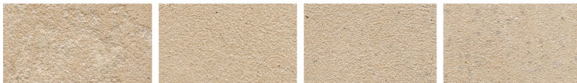
Obr. 63 – Vzorčky hliněné omítky PICAS s kaseinem po vystavení povětrnostním vlivům (archiv autora)
