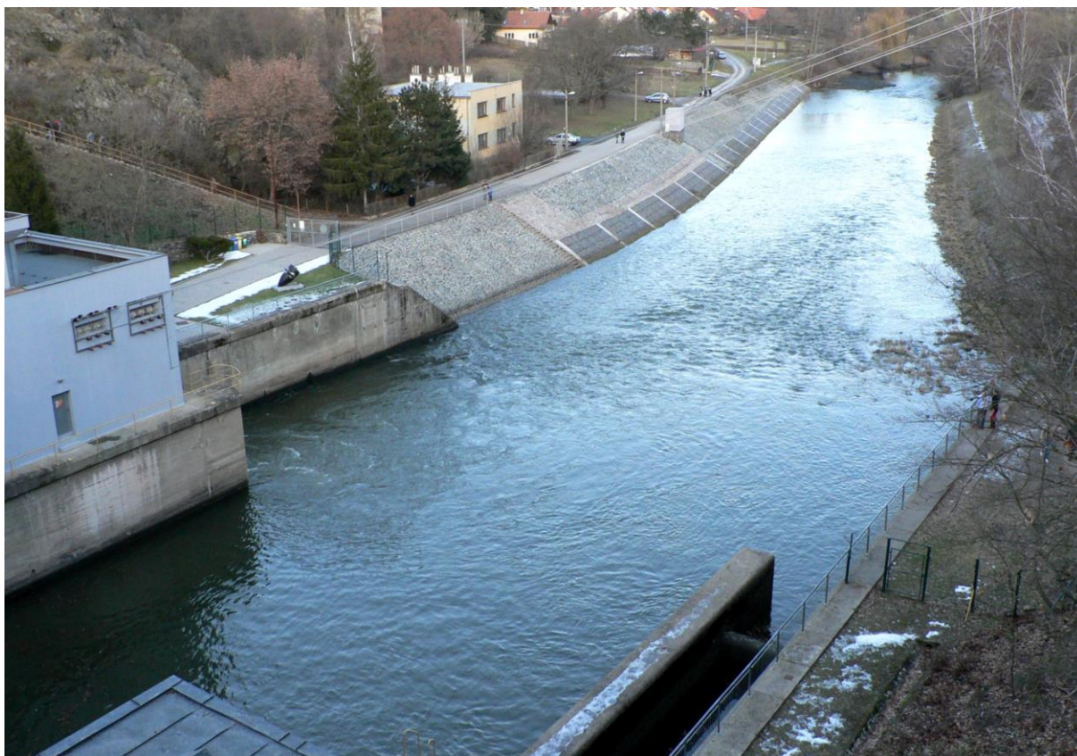
Obrázek č.11: Řeka Svatka pod hrází vodní nádrže Brno
