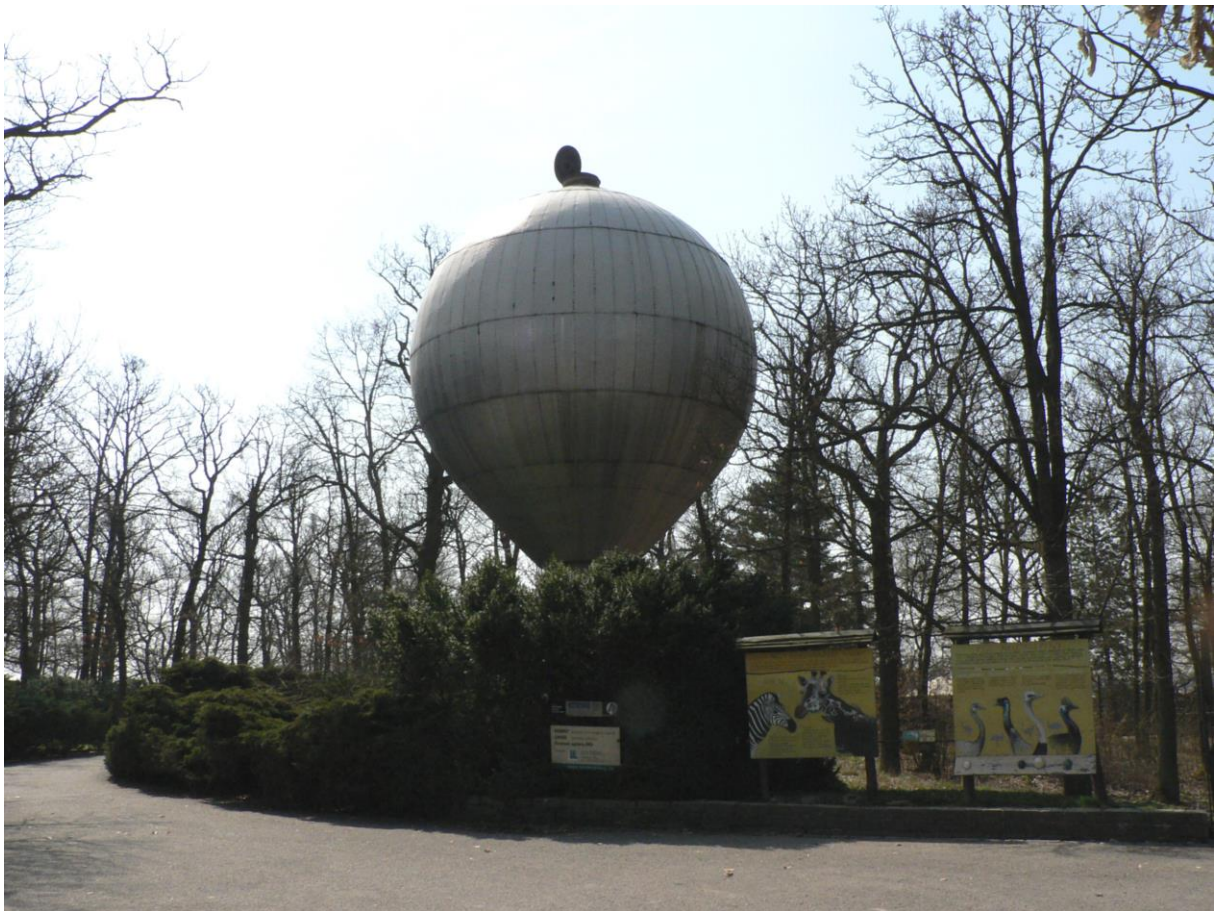
Obrázek č.8: Vodojem na užitkovou vodu
