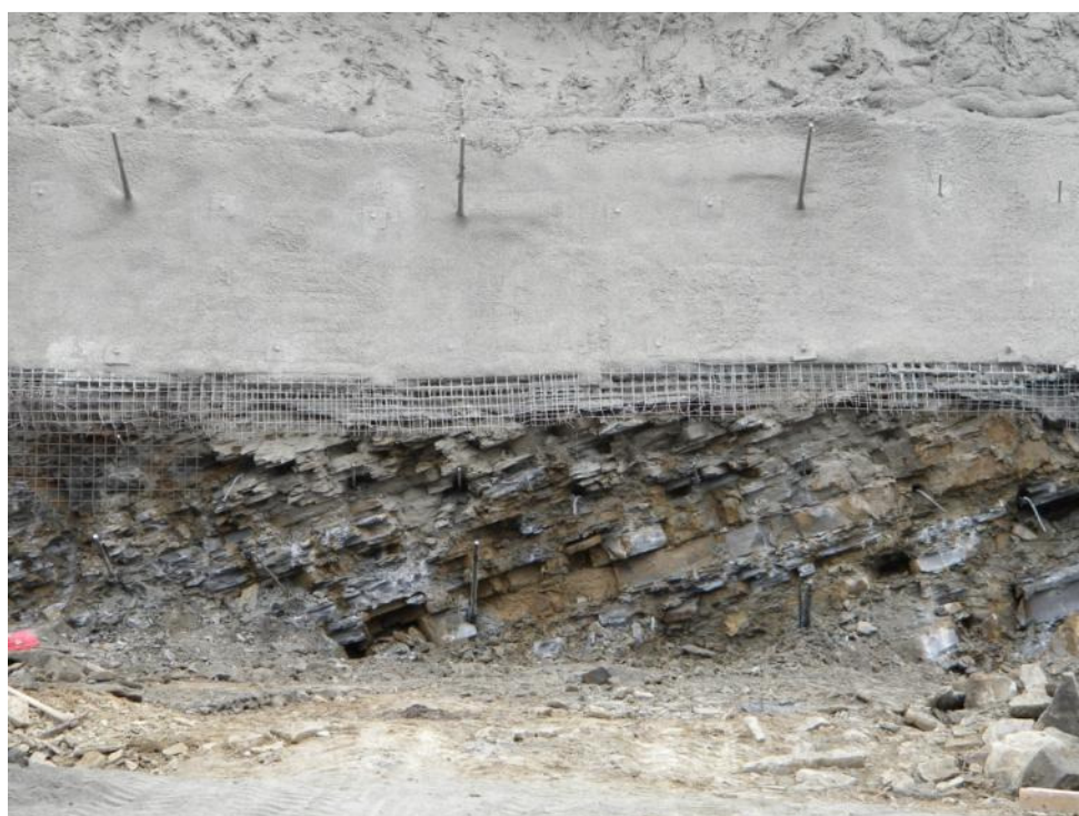
Obr. 2-7: Etapovité zhotovenie zabezpečenie klincovaním
