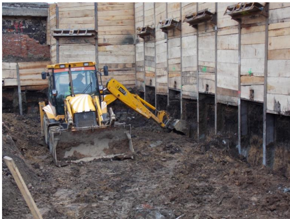
Obr. 2-4: Budovanie záporového paženia
