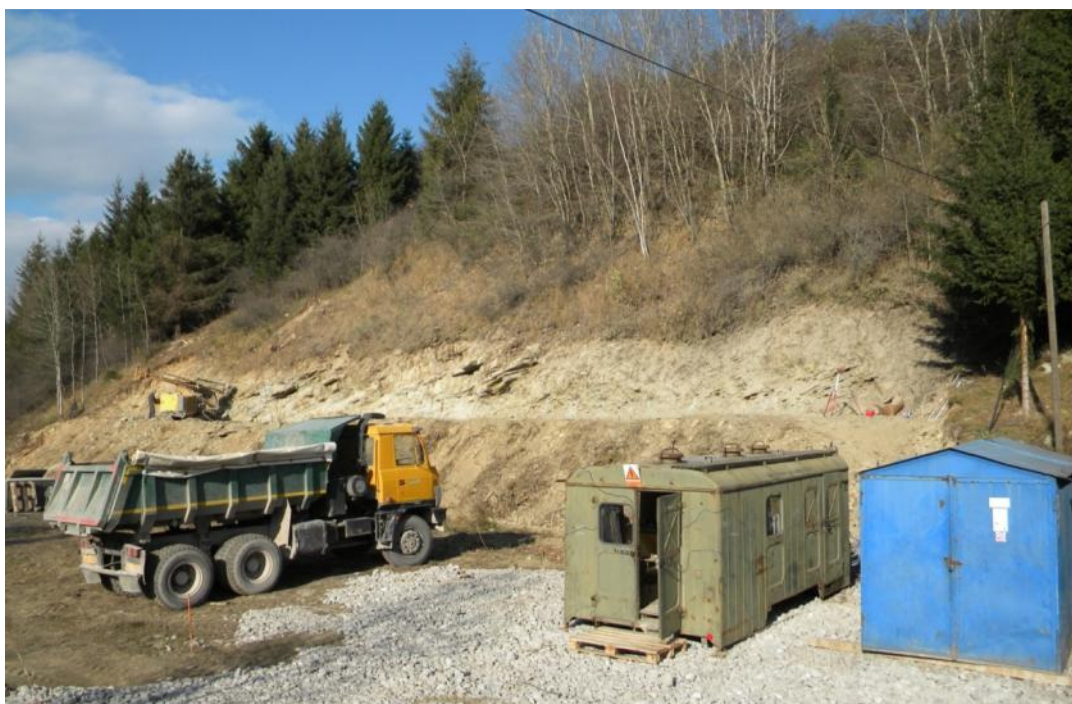
Obr. 4-1: Odkopanie prístupovej plošiny podľa technologického bodu a)
