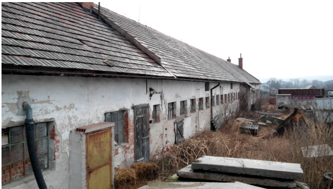
Obr. 9.4 Boční pohled na budovu [vlastní práce autora]
