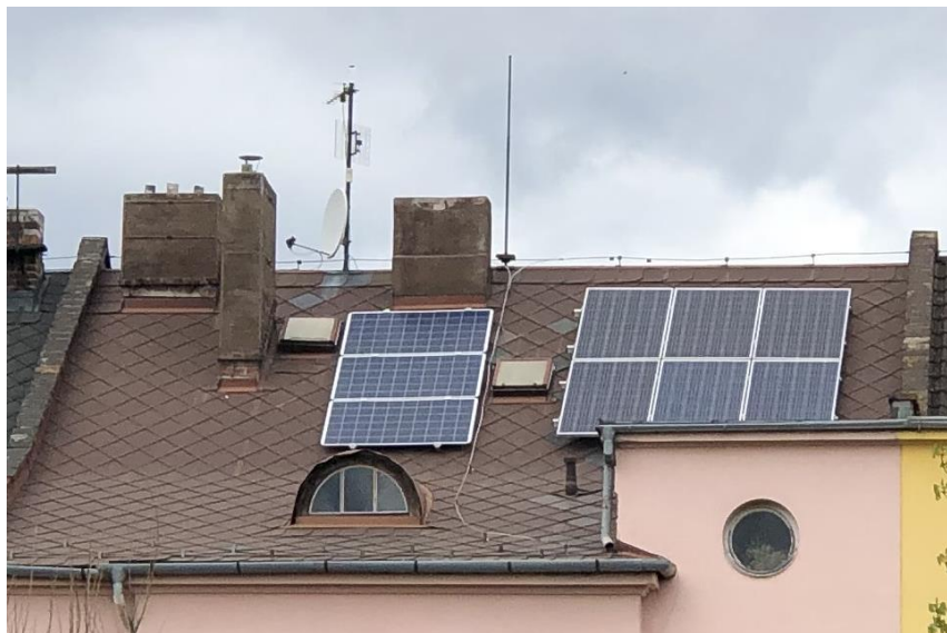
Obr. 6.1-1 Záběr FV pole na střeše budovy
