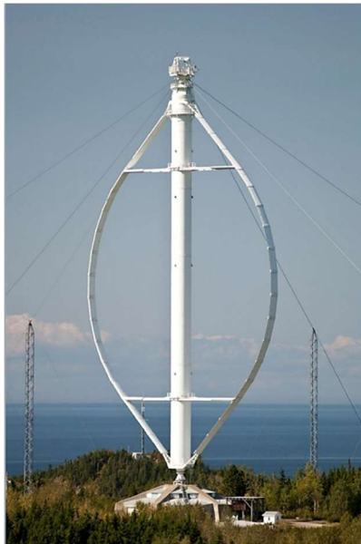
Obr. 3.9: Darrieova turbína s lopatkami ve tvaru \Phi [21].
