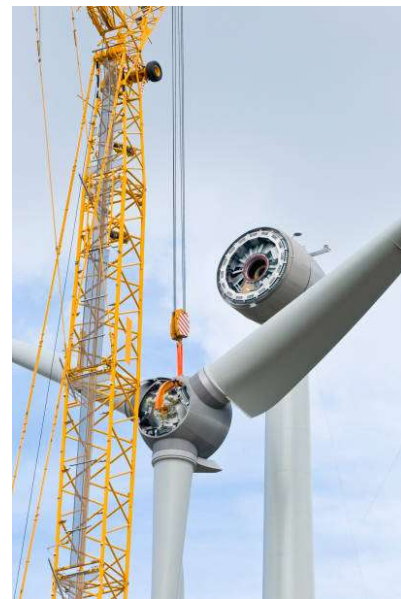
Obr. 4.2: Instalace rotorové hlavy na VTE [95].
