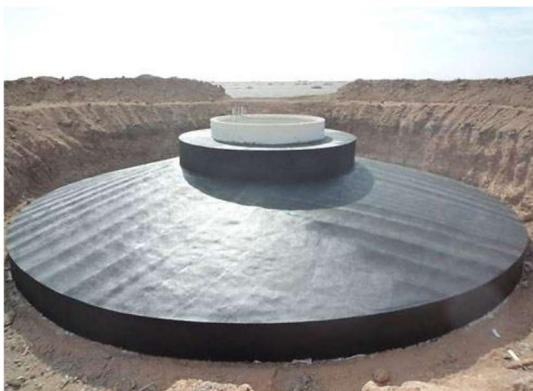
Obr. 4.7: Plošné základy VTE [35].
