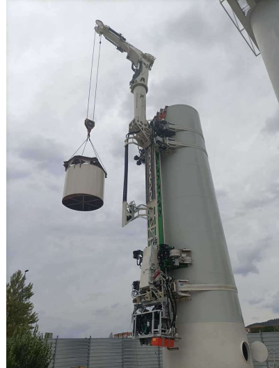
Obr. 4.6: Šplhající jeřáb [29].
