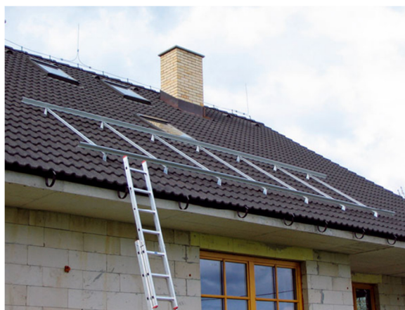
Obr. 1.9 Nosná konstrukce kolektorů[6]
