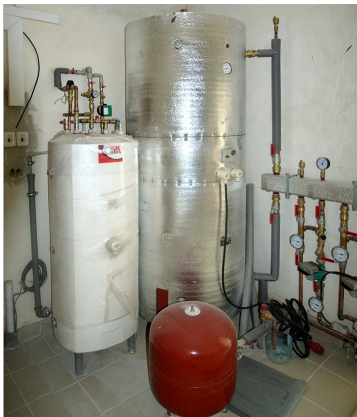
Obr. 2.9 Solární zásobník 200 l a 1000 l připravený na montáž solárního systému
