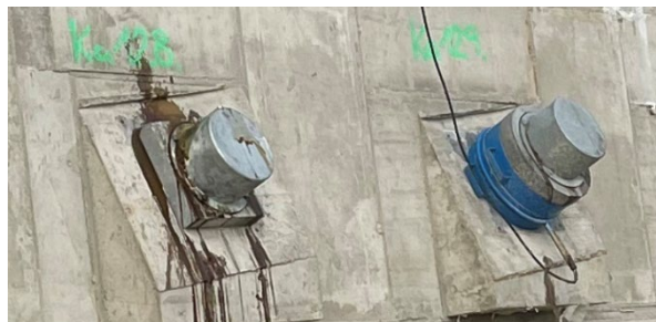
Obr. 2-5 Víka trvalých kotev, kotva vpravo vybavena siloměrem, foto: autor
