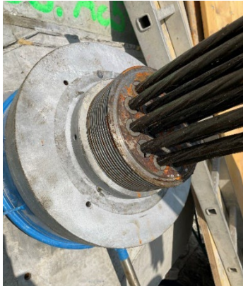
Obr. 2-4 Detail kotevní hlavy se siloměrem (modrý prstenec), foto: autor
