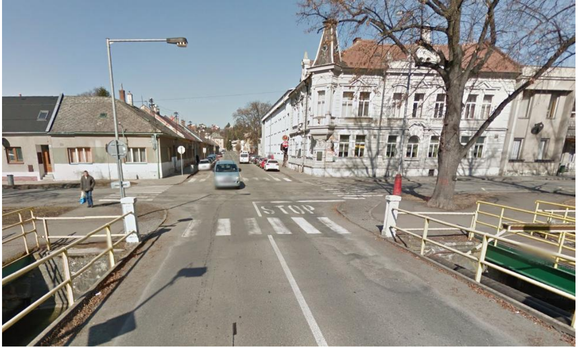
Obrázek 7-20: Křižovatka ulic Masarykova – Krampolova před rekonstrukcí [37]
