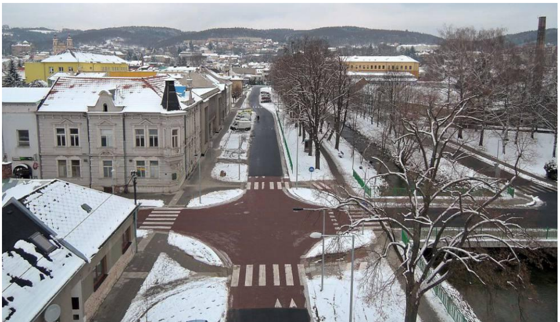
Obrázek 7-21: Křižovatka ulic Masarykova – Krampolova po rekonstrukci [38]
