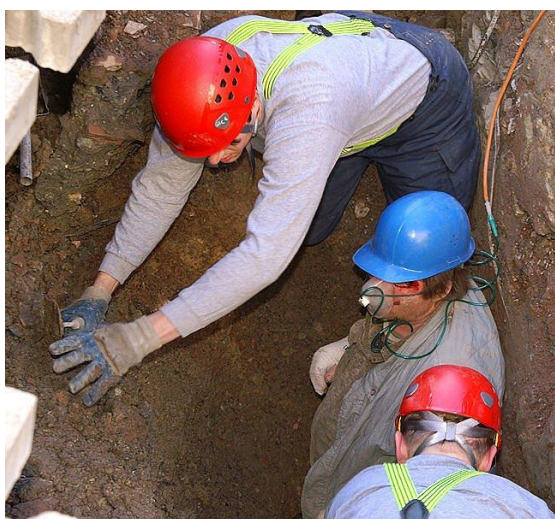
Obr. č. 5: Dělník v zasypaném výkop [vlastní]
