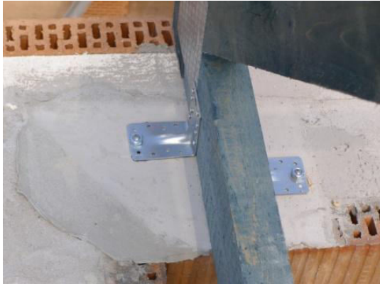
Obr. 4.8: Odsazení úhelníků od sebe (zdroj: [5])
