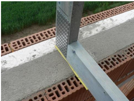
Obr. 4.9: Podložení hydroizolačním páskem (zdroj: [6])
