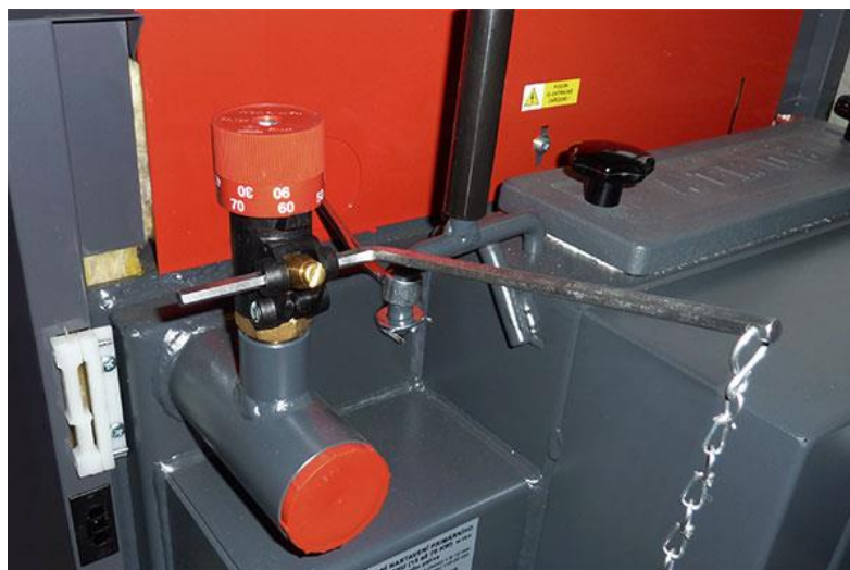
Obrázek 13 - Regulátor tahu (zdroj: www.atmos.cz )
