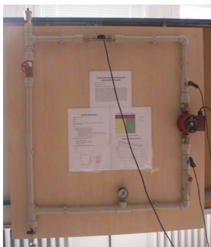
obr. 19 - Zkušební okruh pro zjišťování hydraulických vlastností oběhového čerpadla
