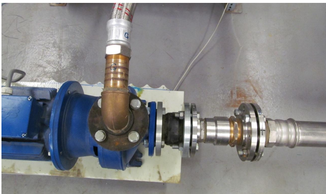
Obrázek 24: Detail připojení čerpadla do okruhu
