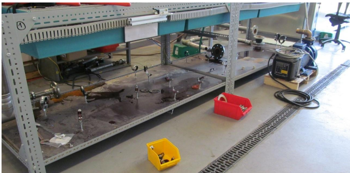
Obrázek 21: Stav podkladové desky po odstranění potrubí
