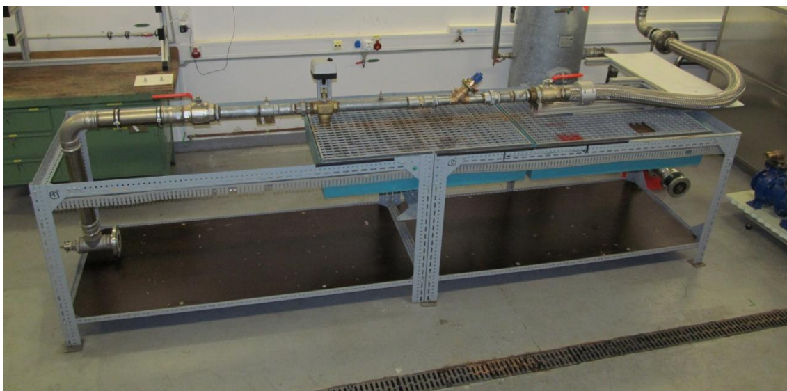
Obrázek 22: Testovací trať připravena na montáž nového potrubí
