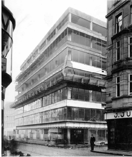
Montáž obvodového pláště
