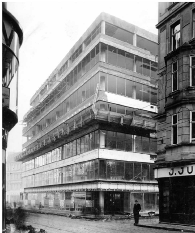
Montáž obvodového pláště
