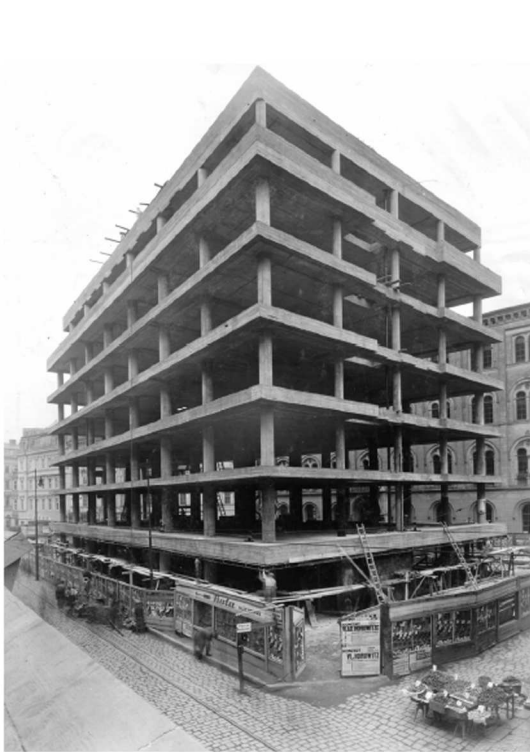
Pohled na železobetonový skelet (6.pater)
