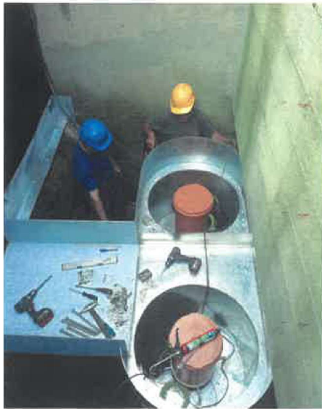
Obr. 8 – Montáž turbín v horizontálním provedení [10]
