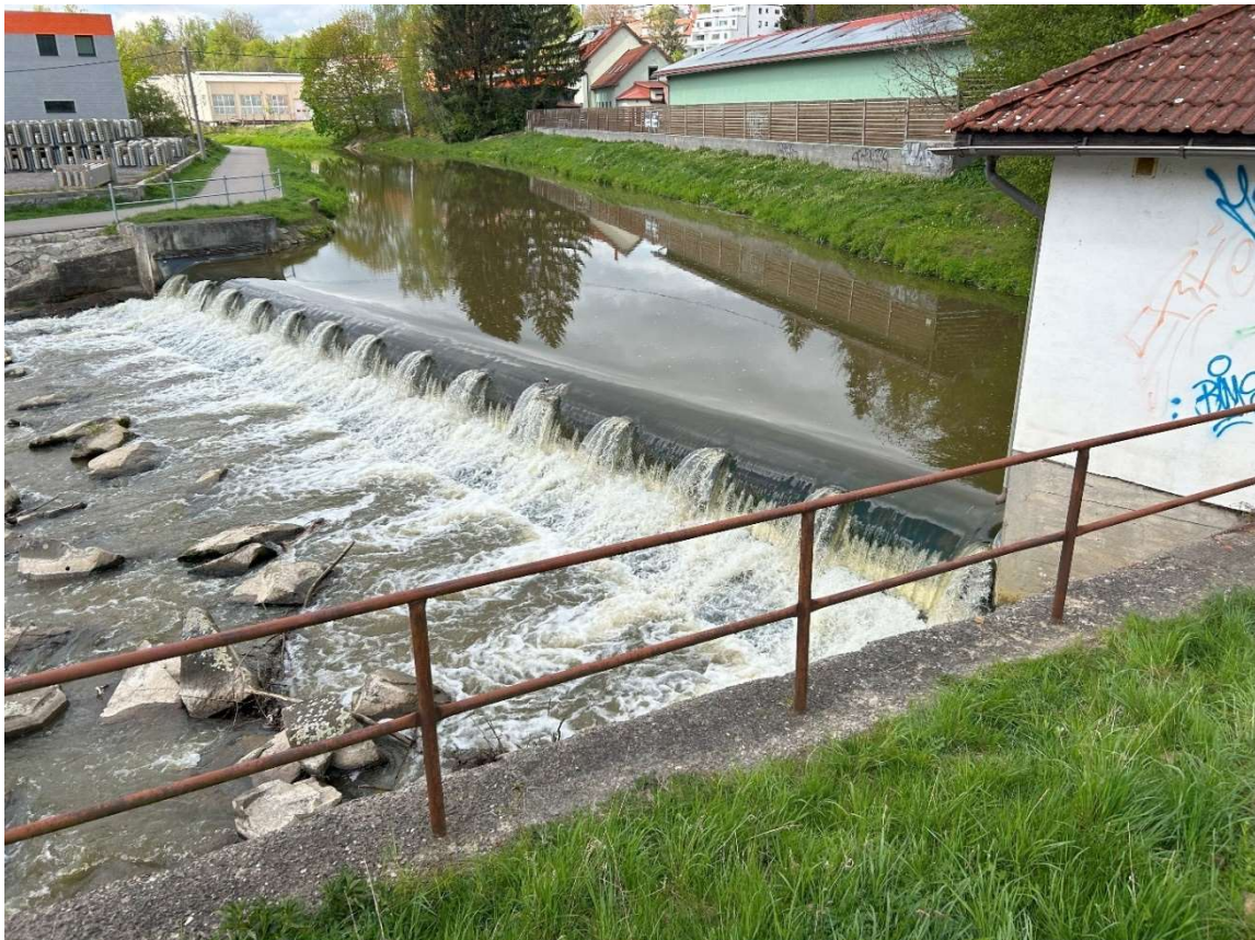
Obr. 2 Stávající stav vakového (Pekárkova) jezu [4]
