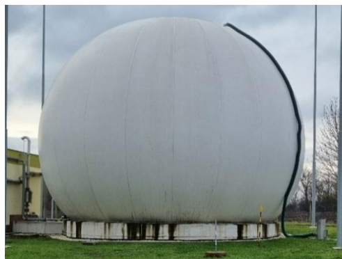
Obr. 84 Textilní dvouplášťový plynojem STTALER B9 117/250 (1 040 m 3 ) [107]
