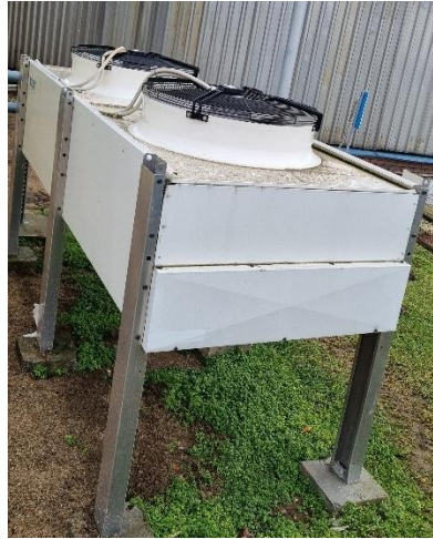
Obr. 72 Výust' z terciární chladícího okruhu [107]
