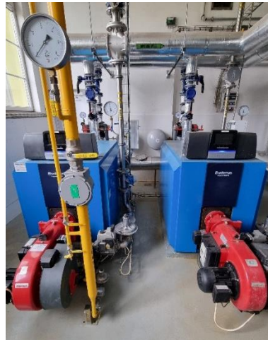
Obr. 83 Plynové kotle Buderus Logano GE 315 s hořáky Weishaupt [107]
