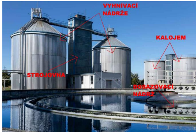
Obr. 79 Technologie pro výrobu elektrické energie [123]
