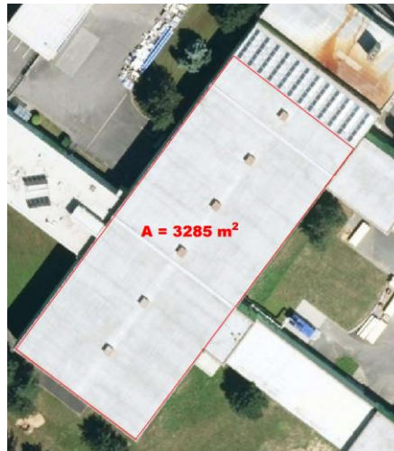
Obr. 68 Střecha budovy ÚV Bzenec pro FVE o výkonu 600 kWp [89]
