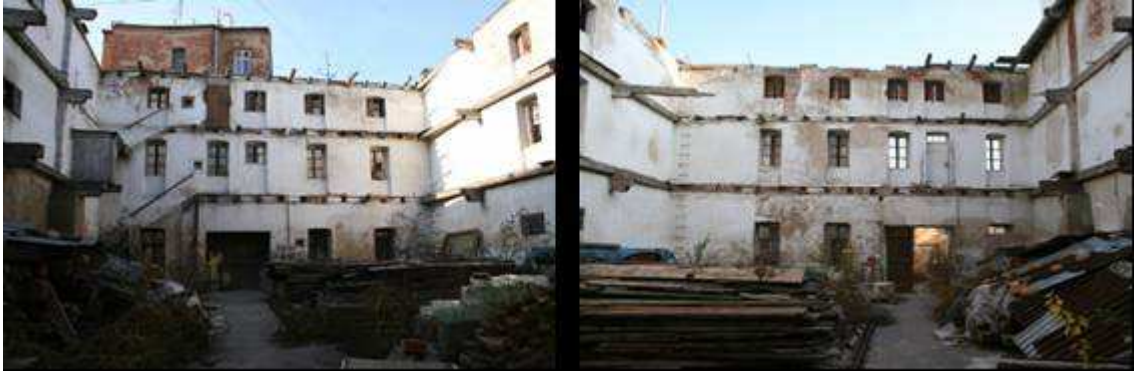
Obrázek 3: Současný stav objektu Solnice
