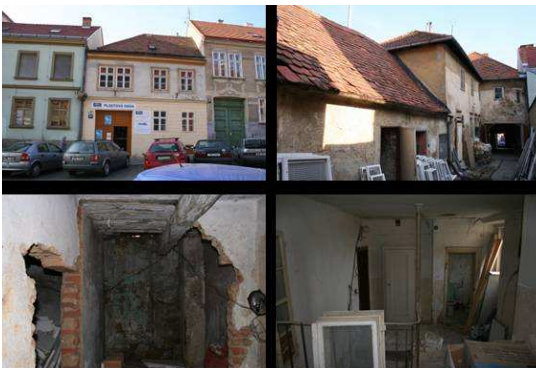
Obrázek 2: Současný stav objektu Horní česká
