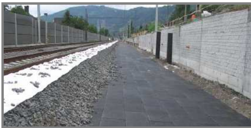
Obr.17 Použití antivibračních desek[25]
