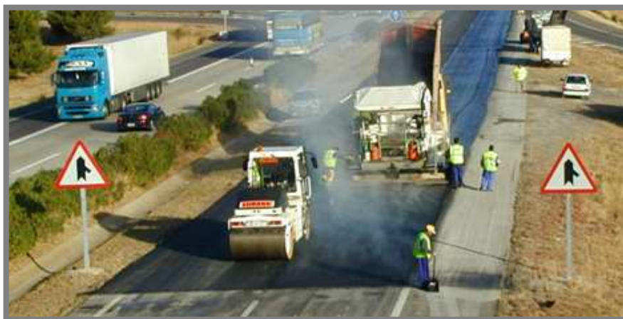
Obr.16 Nový povrch vozovky, Španělsko
