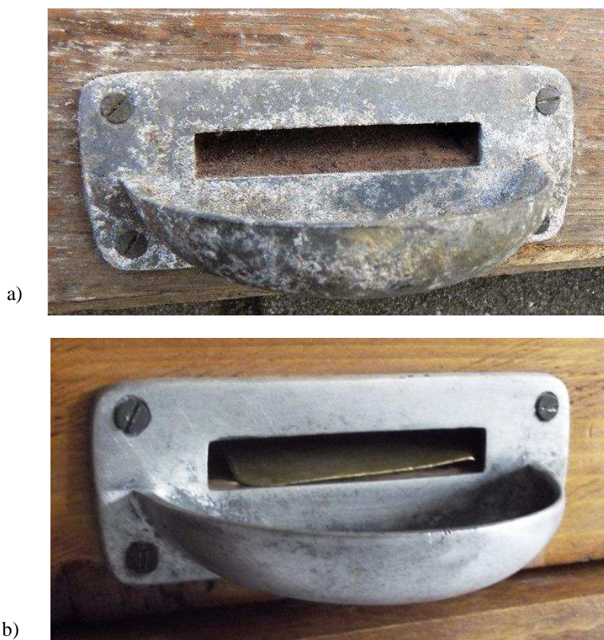
Obr. 3.9 Výherní miska a) před renovací b) po renovaci.
