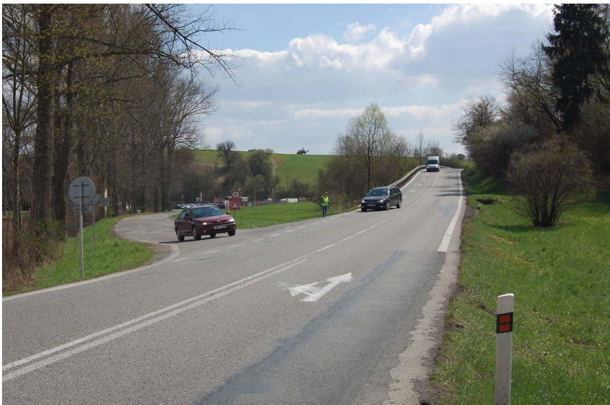
Foto 8 - místo č. 1D – I/43 lokalita Svitávka, křižovatka se silnicí č.37420 (směrem od Letovic) [9]
