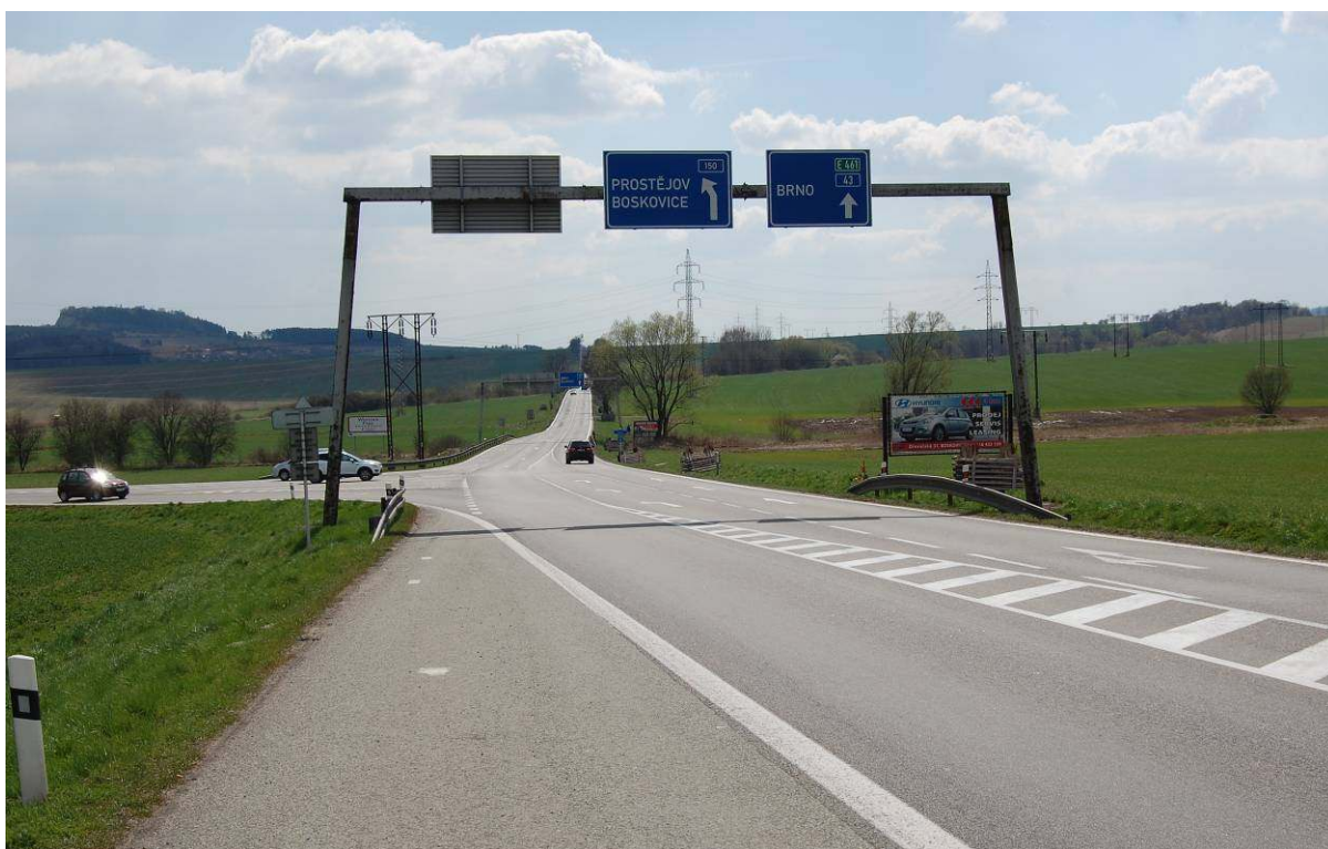
Foto 5 - místo č. 1B – I/43 lokalita Sebranice, křižovatka se silnicí II/150 (směrem od Letovic) [9]
