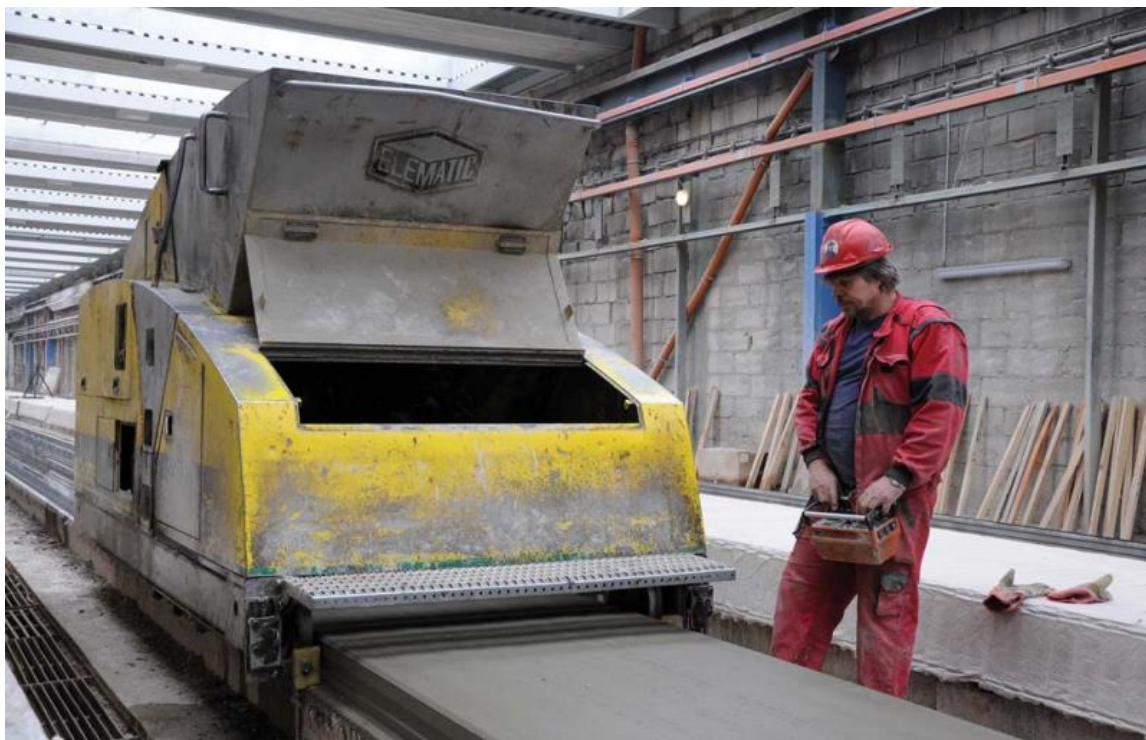
Obr. 2.1.2 – Výroba předem předpjatých stropních panelů Spiroll [3].
