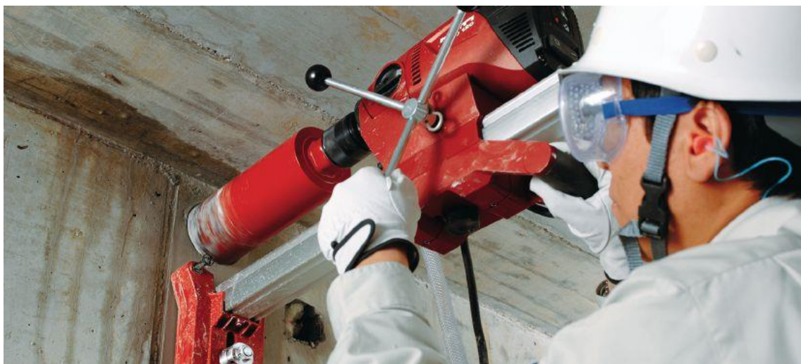
Obr. 2.3.8 – Vodorovné jádrové vrtání diamantovou korunkou [33].
