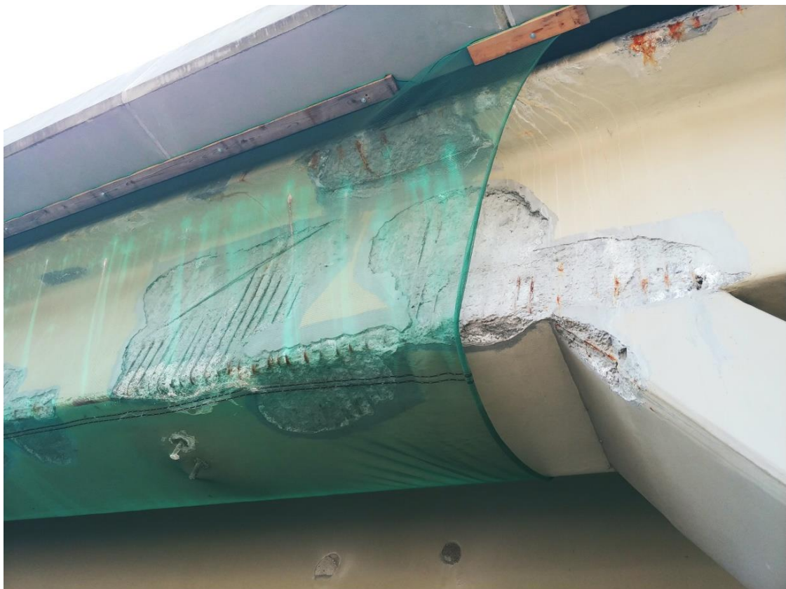
Obr. 3.1.3 – Provizorní opatření pro zajištění bezpečnosti provozu na komunikaci.
