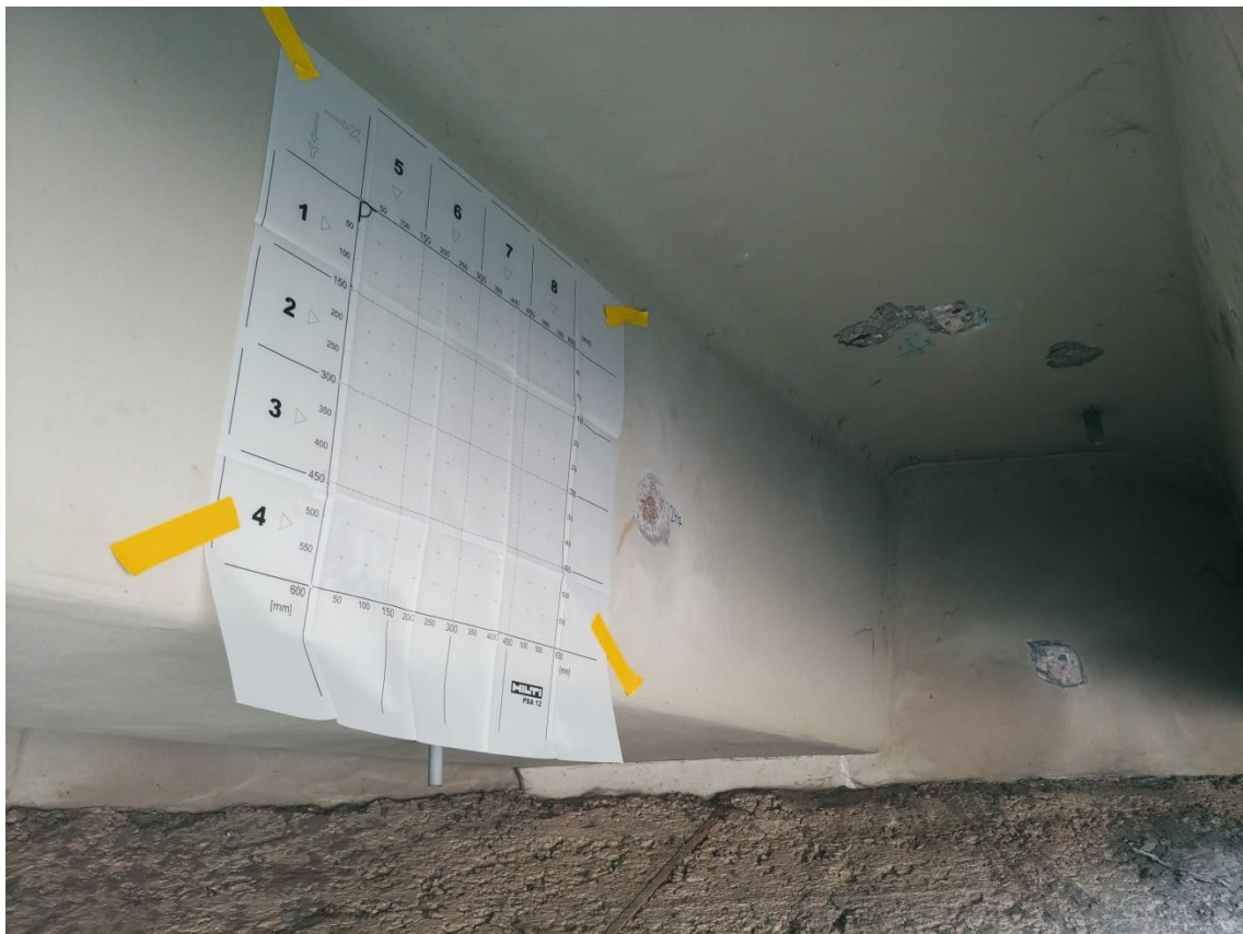
Obr. 3.2.2 – Boční líc nosníku s přiloženým rastrem pro provedení plošného skenu.
