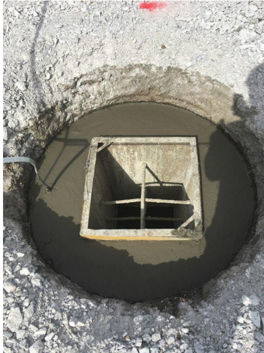
Obr. 60 Příklad monolitické kalichové patky [46]
