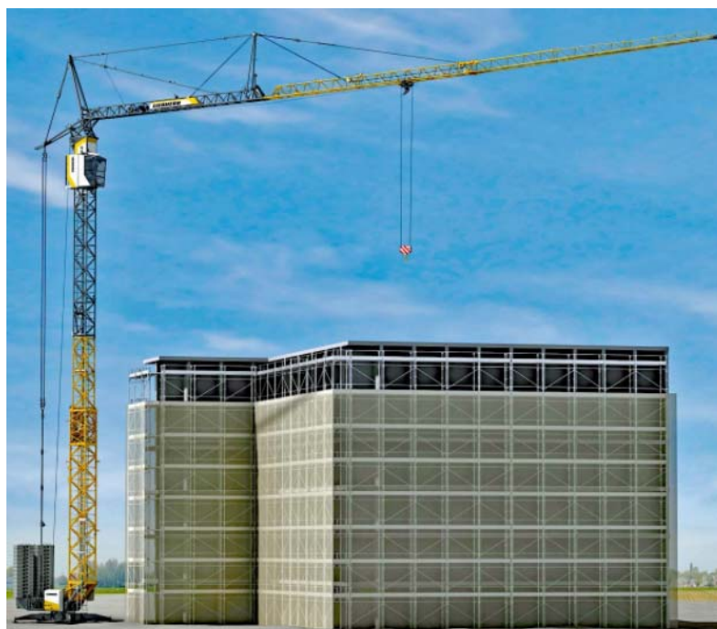
Obr. 15 Věžový jeřáb Liebherr 81 K.1
