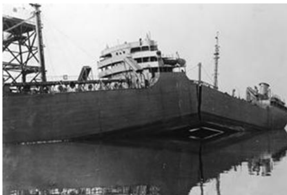
Obr. 1: Loď třídy Liberty poškozená křehkým lomem.
