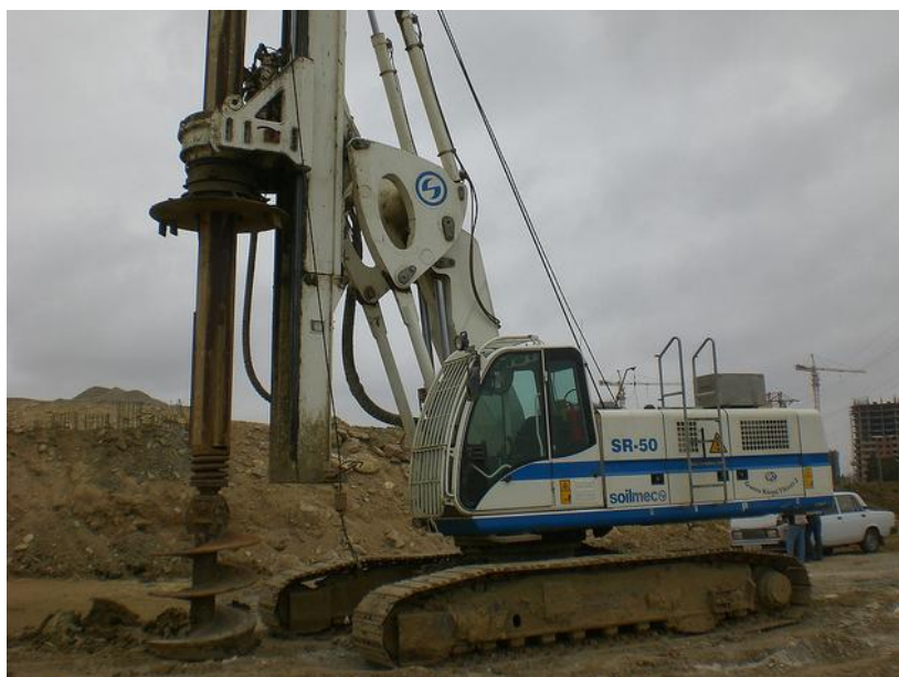
Obr. 7.2 Vrtná souprava SOILMEC SR 50 při práci [27]
