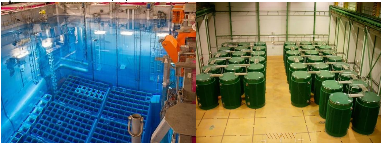
Obr. 17 a) bazén vyhořelého jaderného paliva, převzato z [54], b) suchý mezisklad, převzato z [55]
