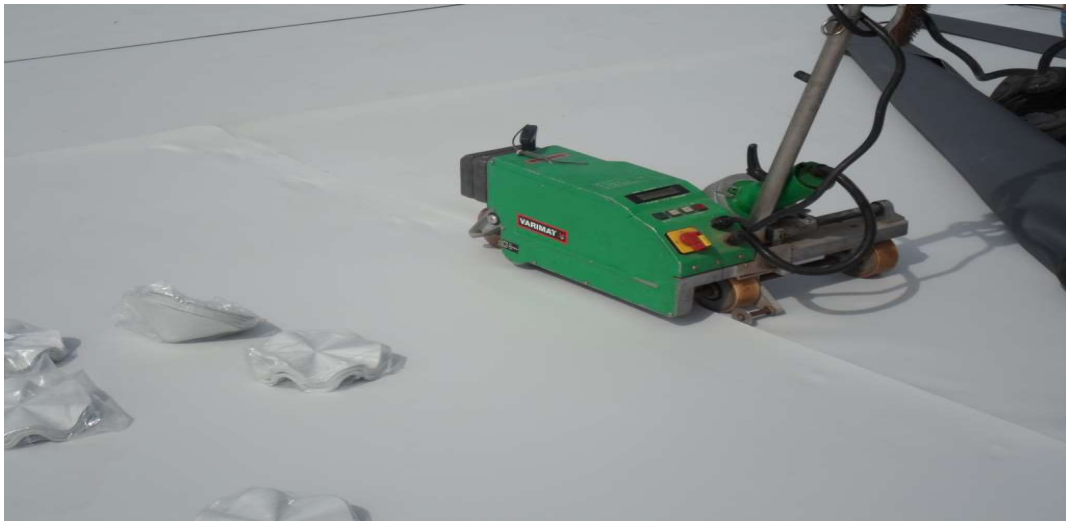
Obrázok č. 10: Práca so zväracím automatom (Zdroj: Vlastné spracovanie)
