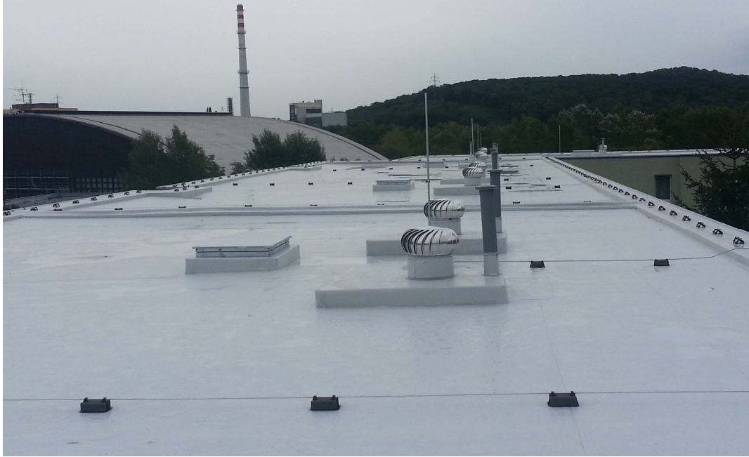
Obrázok č. 9: Zrealizovaná rekonštrukcia (Zdroj: Vlastné spracovanie)
