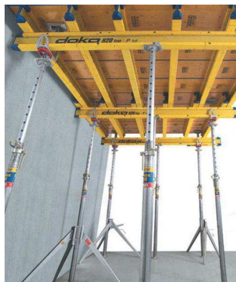
Obrázek 17 – Bednění předsazeného stropu
