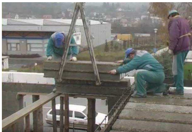
Obrázek 18 – Ukládání panelů https://www.youtube.com/watch?v=snLYdrtXqbE
