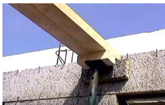
Obrázek 15 – Podbednění stropu u stěny autor
