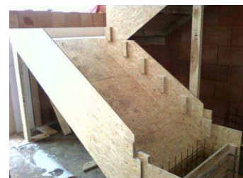
Obrázek 22 - Bednění schodiště http://www.arw-stavebni.cz/fotogalerie/-/schodiste?pg=&fotogalerie_zobrazeni=velka&fotogalerie_poradi=vychazi&fotogalerie_poradi_rev=0&fotogalerie_
