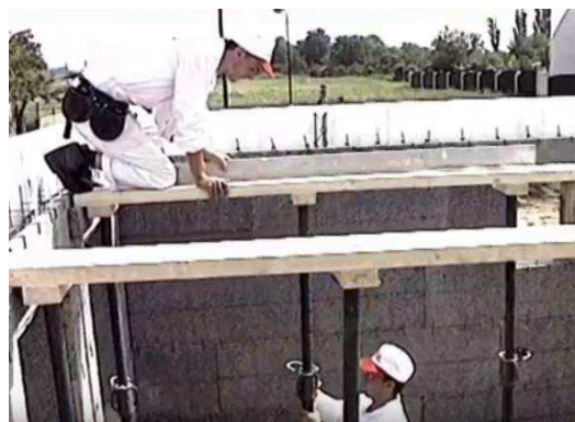
Obrázek 14 – Podbednění stropu ( https://www.youtube.com/watch?v=wJZnZ1BYJZc )
