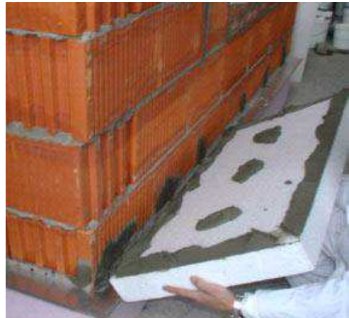
Obrázek 3 - Zteplené zdivo PTH ( http://www.ceskestavby.cz/clanky/zateplete-aby-vas-zima-nezaskocila-19069.html )
