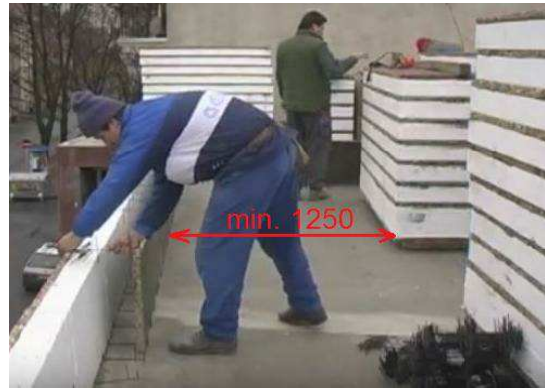
Obrázek 1 – Pracovní a materiálový prostor na stropní konstrukci ( https://www.youtube.com/watch?v=93DZBLcK0BE )
