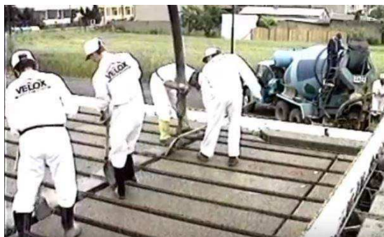
Obrázek 21 – Betonáž stropní konstrukce https://www.youtube.com/watch?v=wJZnZ1BYJZc
