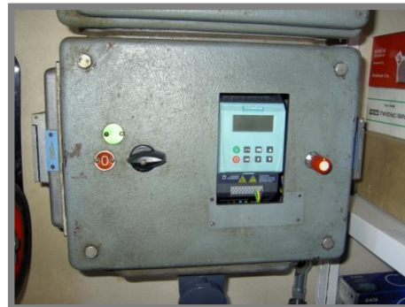
Obr. 19 Frekvenční měnič
