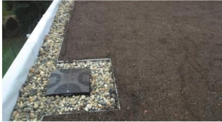
Obrázek 5 Střešní vtok s revizní šachtou [9]
