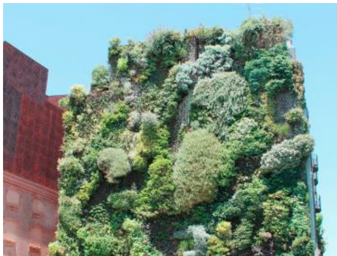
Obrázek 7 Ukázka realizace živé stěny [13]
