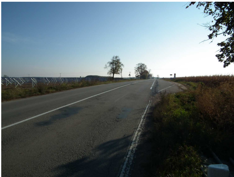
Obr. 12 Bývalé směrové šipky – pohled od Ledců
