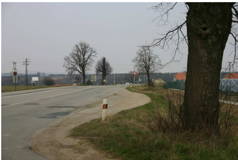
Obr. 40 Pohled ze směru od Hrušovan u Brna k Ledcům – 242m
