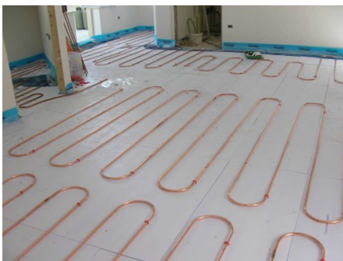
Obr. 19 Podlahové vytápění provedené z měděného potrubí [13]
