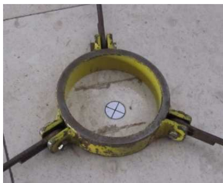
Obr. 8 Ukázka stabilizace pomocných měřických bodů v interiéru
