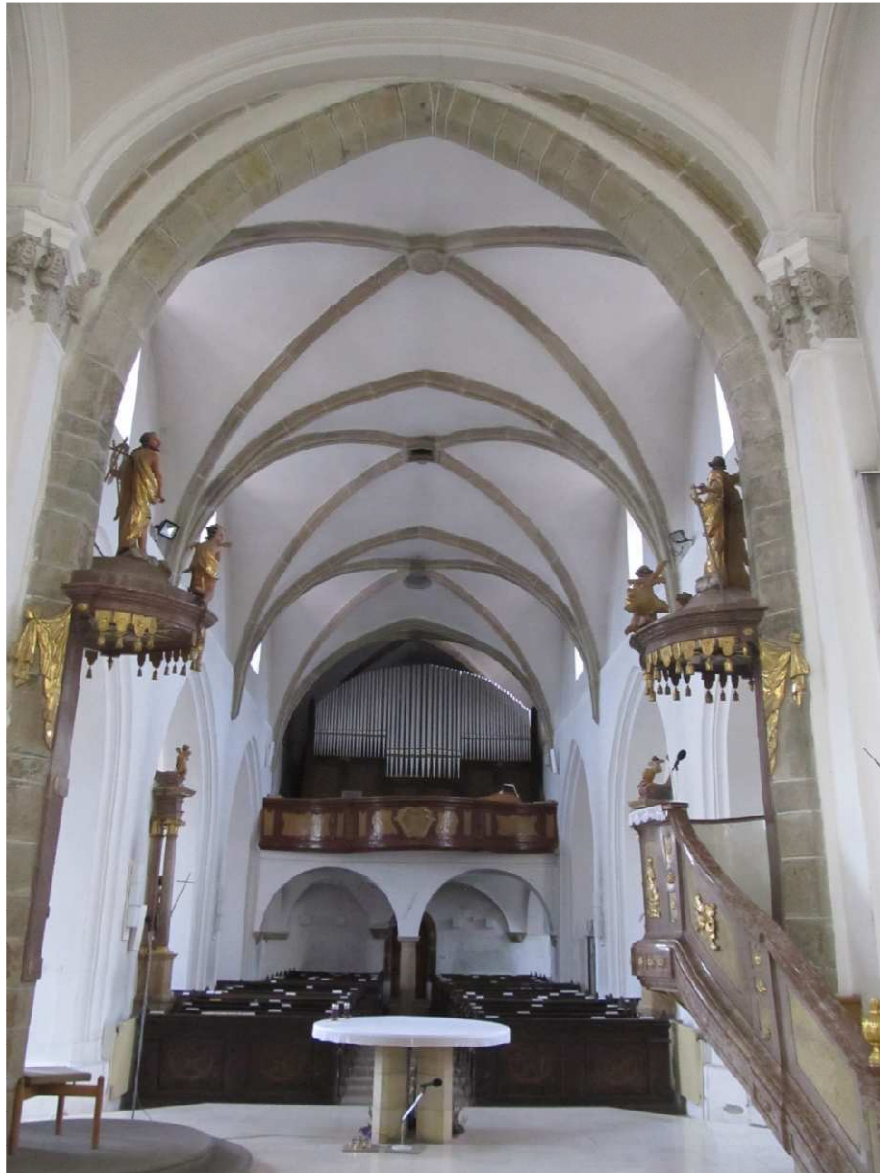
Obr. 17 Gotické klenby s vystouplými žebry nad hlavní lodí.
