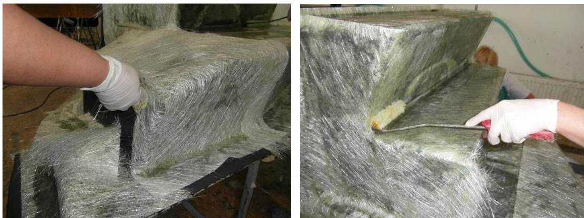
Obr. 1.14 Aplikace výztuže (vlevo), prosycení výztuže pryskyřicí (vpravo).
