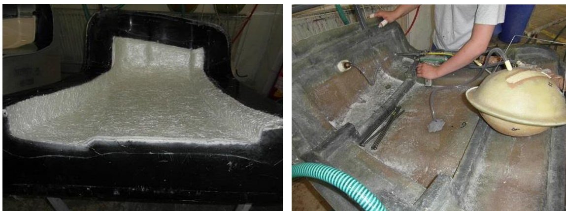
Obr. 1.17 Založení objemové výztuže (vlevo), injektáž pryskyřice (vpravo).
